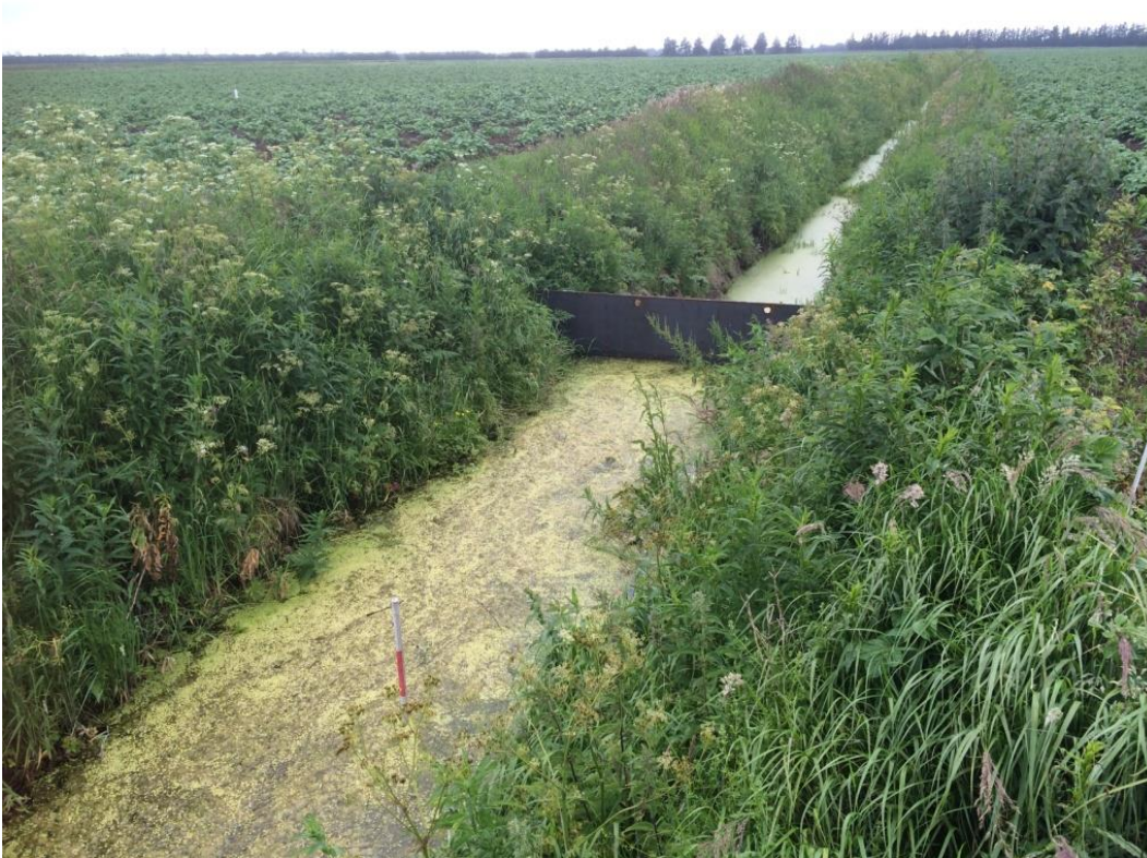
Billede 36. Kontrolleret dræning med jernplade juli 2015. Foto: Kirsten Birke Lund
