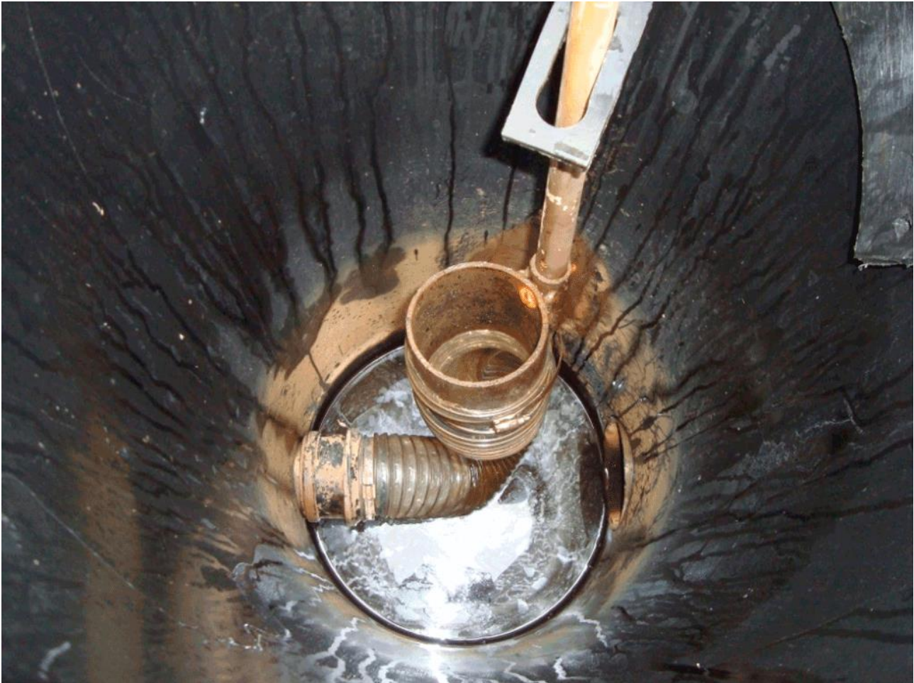
Billede 13. Brønd til regulering af vandstand. Vandstanden i marken vil være den samme som højden på udmundingen af flexslangen. Foto: Kristoffer Piil
