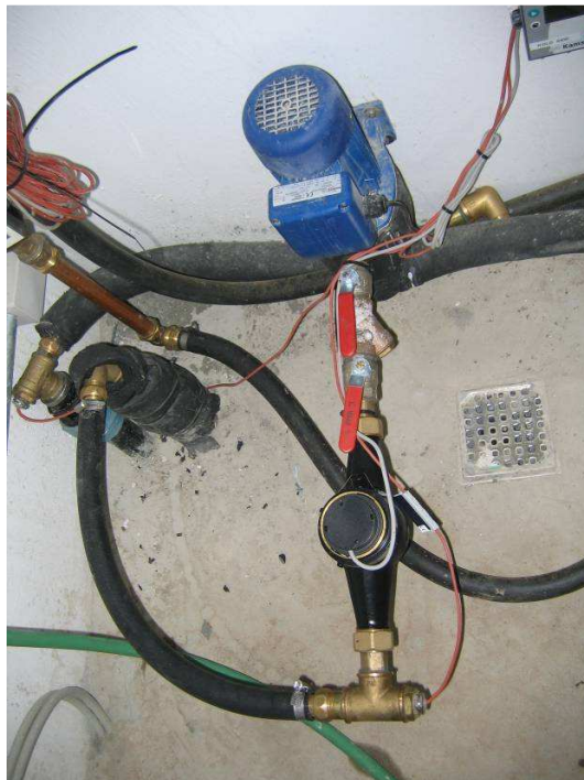
Vingehjuls-flowmåleren – monteret parallelt med gulvet.
