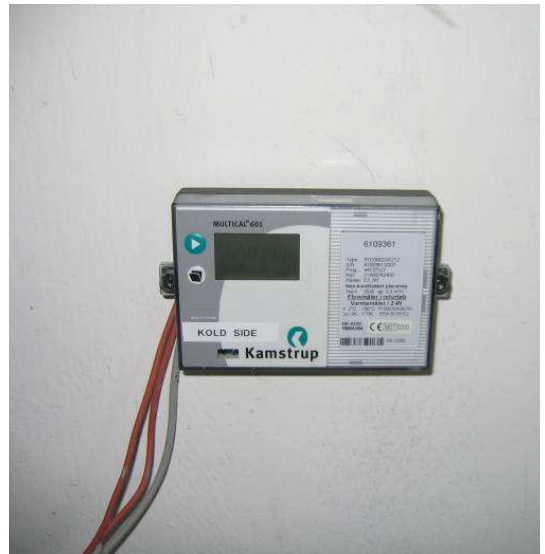
Regneværket til vingehjuls-flowmåleren.
