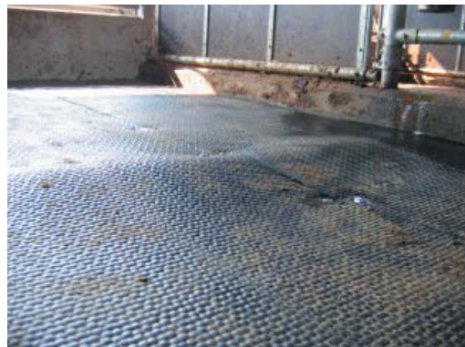
Figur 5.18 Den øverste gummimåtte i boks 5 havde udvidet sig.
