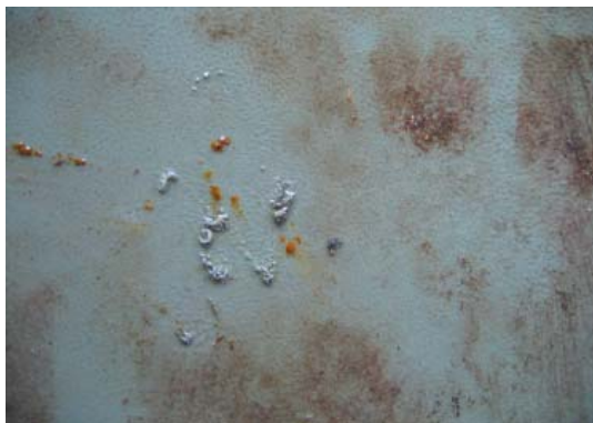
Figur 6.1 Underlag i boks 8 smuldrede i overfladen ved højtryksrensning på indtørret fastgroet gødningsklar.
