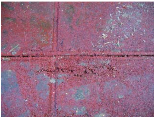
Figur 5.17 Brud i overfladen i gummifliseunderlaget i boks 4.
