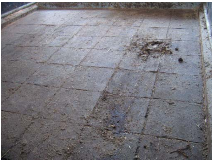
Figur 5.11 Boks 4. En række fliser sunket i fliserne hulrum og en flise knækket sammen.
