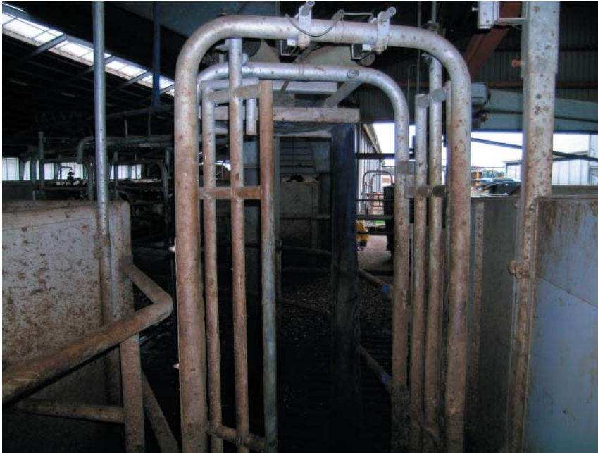
Figur 4.1 Texaslåger, der åbner imod koen, kan betyde, at en ko, der bliver presset af bagvedkommende køer, kan kile sig fast. Det skaber uro, og er gulvet glat kan køerne skride ud.
