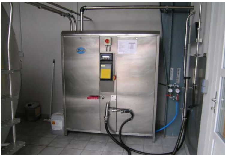
Figur 8. CIP-vaskeanlæg, her i forbindelse med 2x12 sildebens-malkestald.
