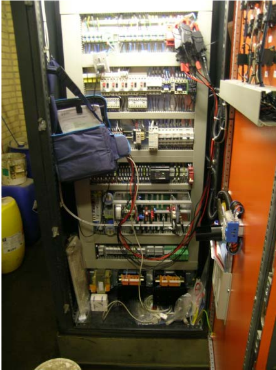
Figur 12. Elmåler monteret i elskab på Gascoigne Melotte.
