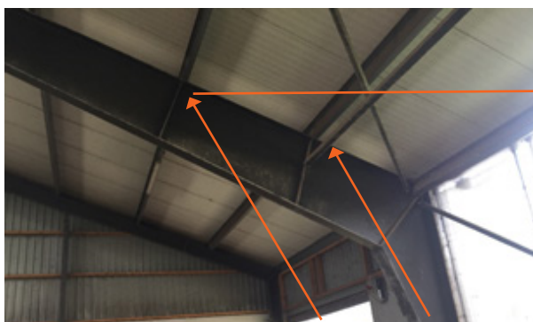
Billede 12 og 13. Kipningsstang kun monteret ved nederste afstivning, øvrige kipningsfastholdelser er ikke etableret.
