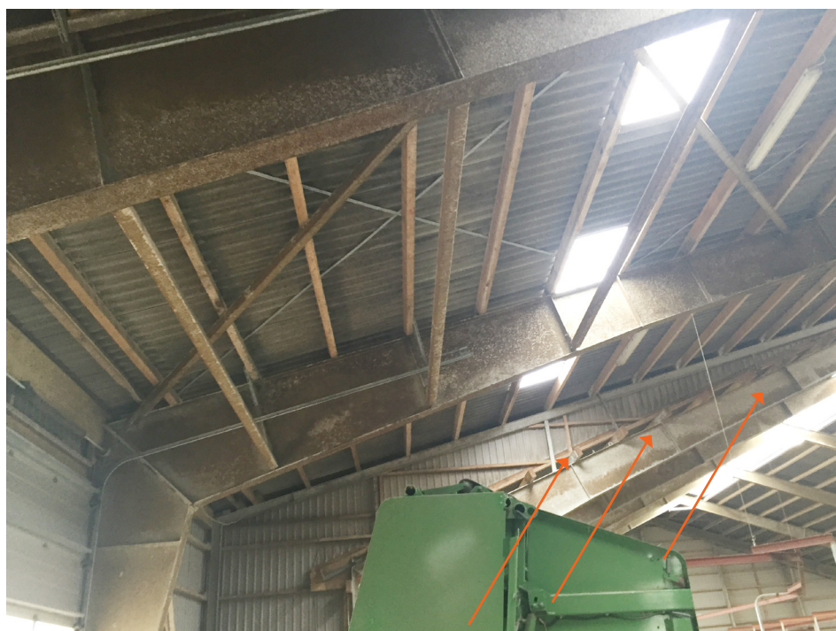
Billede 14. Kipningsfastholdelser forudsat på endefag - ved hævet tagflade – både på tag og facader.
