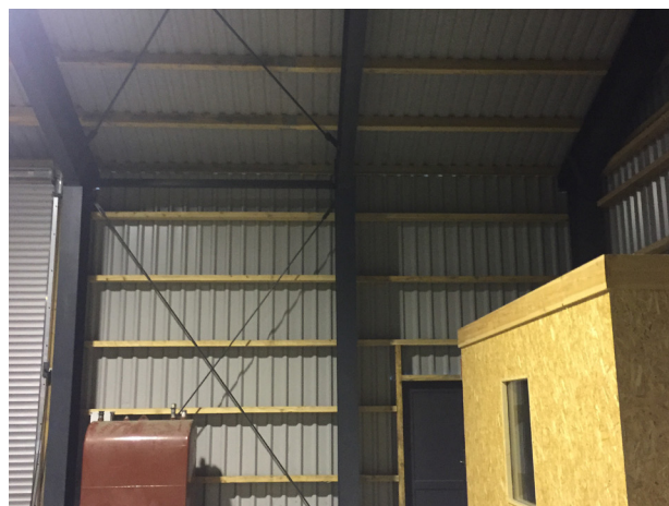
Billede 18 og 19. Typisk placering af vindkryds i andet fag og ikke i direkte kontakt med gavlsøjlerne.
