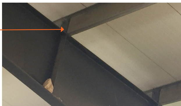
Billede 12 og 13. Kipningsstang kun monteret ved nederste afstivning, øvrige kipningsfastholdelser er ikke etableret.
