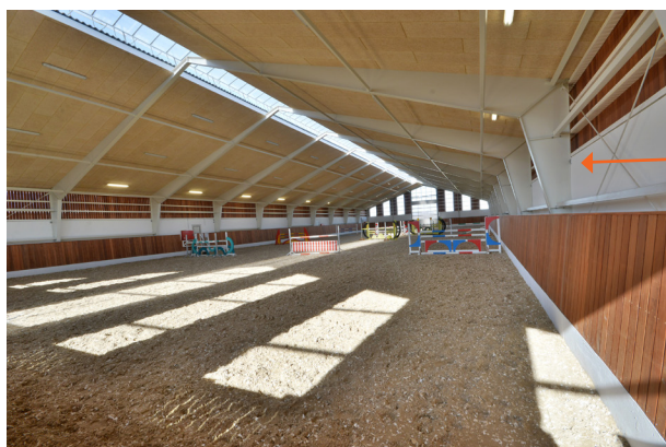
Billede 16. Godt eksempel: Kipningsstænger i både tag og facade.
