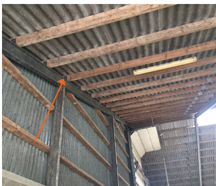
Billede 20. Typisk samling mellem gavlsøjle, gavlramme og ås.
