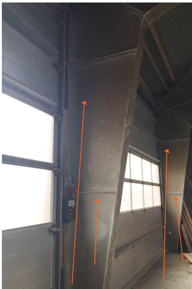
Billede 15. Kipningsfastholdelser forudsat ved porte.
