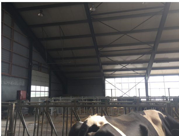
Billede 18 og 19. Typisk placering af vindkryds i andet fag og ikke i direkte kontakt med gavlsøjlerne.
