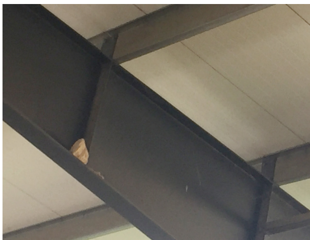
Billede 3. og 4. Kipningsstang ved den eller de nederste åse, mens de øvrige tre til fire kipningsfastholdelsessteder ikke er afstivet, trods indsvøjte kropsafstivninger, der er et tegn på, at spær fabrikken har forudsat en fastholdelse i sin dimensionering.
