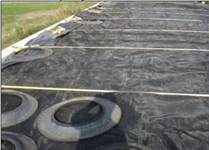
Billede 4. Plansiloanlæg med stropper. Stropperne er forankret i silovæggen.
