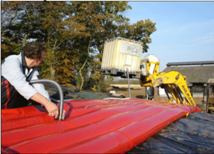
Billede 3. Overdækning med vandmadras. Det er tidskrævende at fylde og tømme madrassen.
