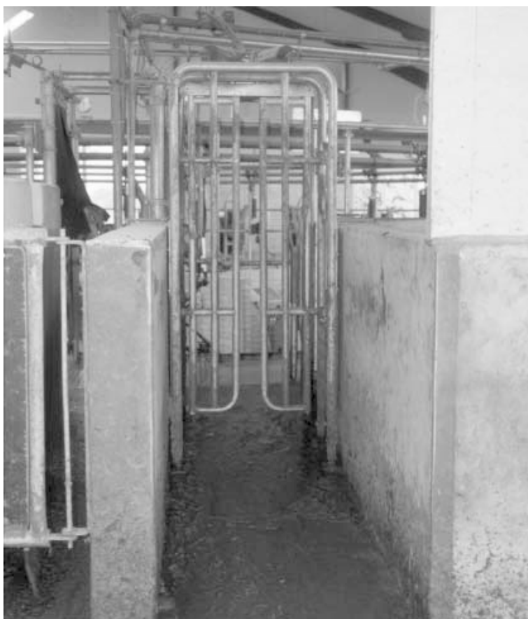
Figur 4.4 Texaslåge ved indgang til karrusel. Lågen bør placeres tæt på karrusellen, og indgangspartiet bør have en bredde på minimum 90 centimeter.
