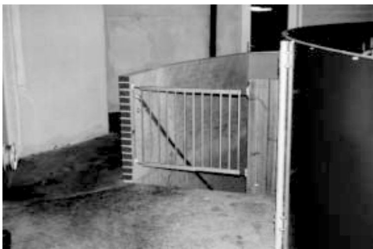
Figur 4.12 Tunnel ind i midten af en indvendig karrusel er en god løsning, men også en forholdsvis dyr løsning. Nedgang i tunnelen er afskærmet med en låge, så personer (specielt børn) ikke kan falde ned i den.
