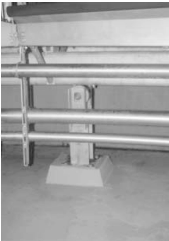
Bukke med bæreruller boltet i gulvet
