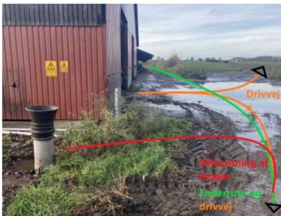
Figur 3: Krydsende, våde/mudrede og urene kørselsveje for gyllevogn, foderrute og drivveje for køer. Køerne er opstaldet i bygningen og foderbordet løber på ydersiden af bygningen sammen med kørselsvejen for foder. Ved afhentning af gylle køres der
