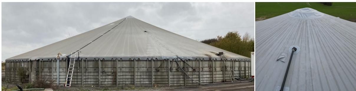
Figur 1 - Billede af Tank A. Det sorte rør langs teltdugen leder gylleluften til faklen. Nærbilledet af sugestudsens og tophætten ses til højre.
