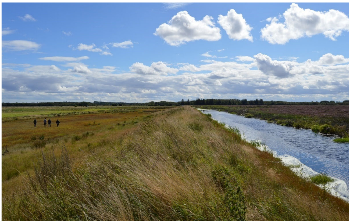
Jordvold med plastikmembran adskiller nu højmosen fra landbrugsarealer. August 2020.
