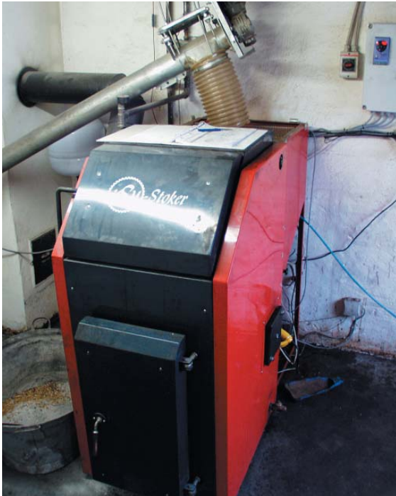
Figur 8.2. 20 kW rapskage-stokerfyr med integreret oliepresser.
