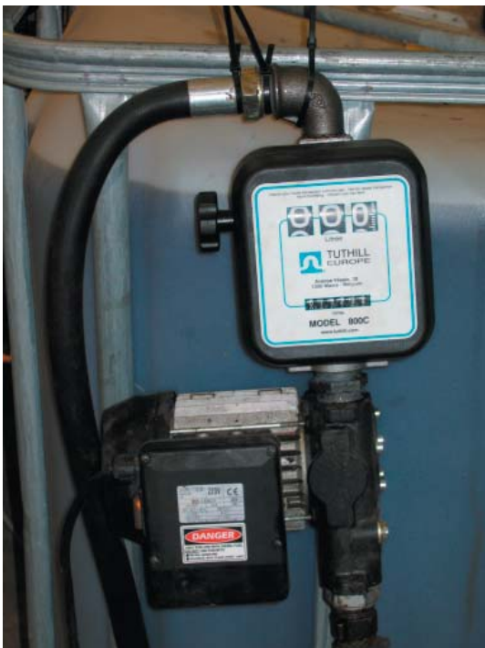
Figur 7.21. Oliepumpe sammenkoblet med kvantummåler (i liter).
