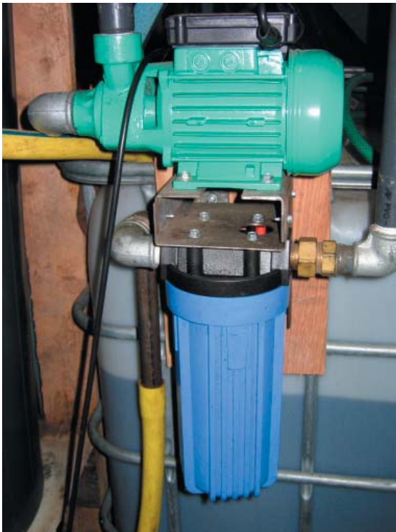
Figur 7.17. Filtersystem med pumpe fra BT.
