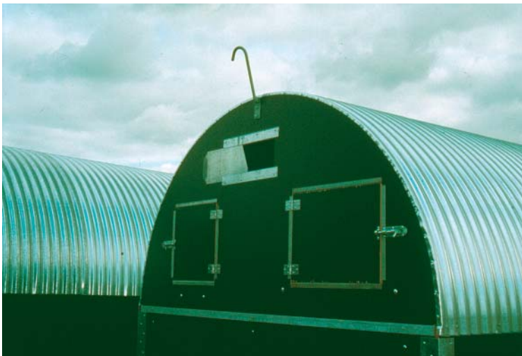
Figur 4.9. Bagvæggen af fælleshytterne set ude fra med låger til opfyldning af kalveblanding og hør, samt en lille ventilationsåbning med skydelåge øverst.
