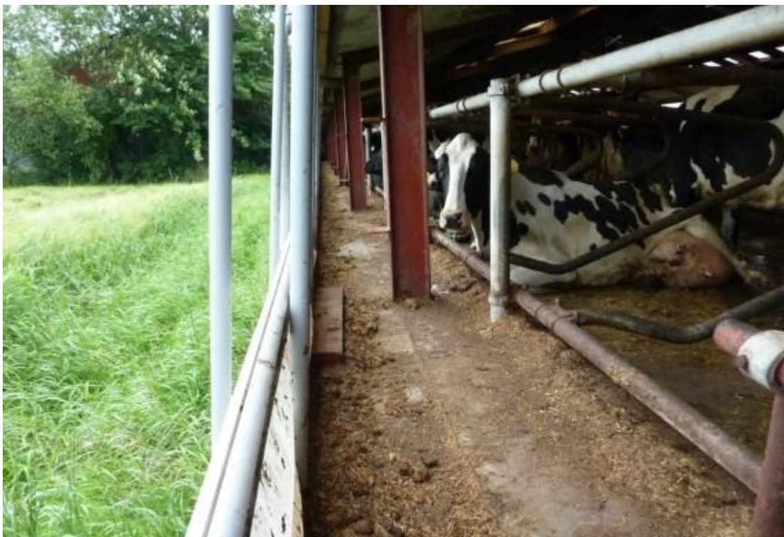
Billede 2. Billedet her viser sengene efter ombygningen. Væggen er væk og gardinet flyttet ud. Det hele ser egentlig helt fint ud.
