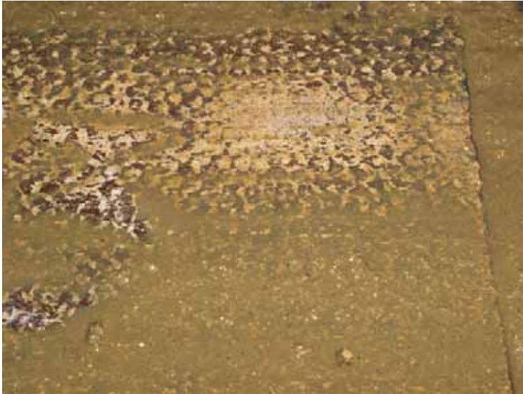
Figur 18. Små områder med glat overflade på trædefladen ved gulvtype 2.
