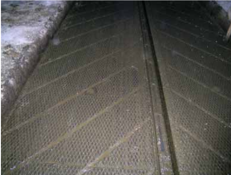
Figur 15. Tilstoppede drænrender ved gulvtype 1.
