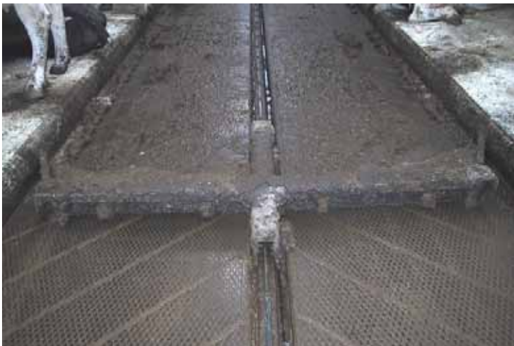
Figur 4. Skrabeanlæg til gulvtype 1.
