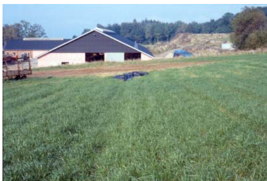
Figur 2.1. Bygninger i læ.
