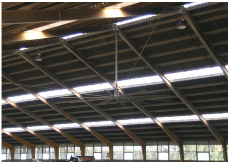
Figur 4.1. Vandret monteret ventilator i sengebåsestald.
