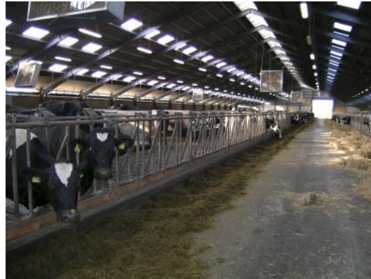
Figur 4.3. Lodret monteret ventilator monteret i sengebåsestald.
