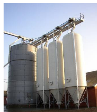
Hvis pladsen indendørs er begrænsende, kan flere råvarer opbevares udendørs i glasfibersiloer
