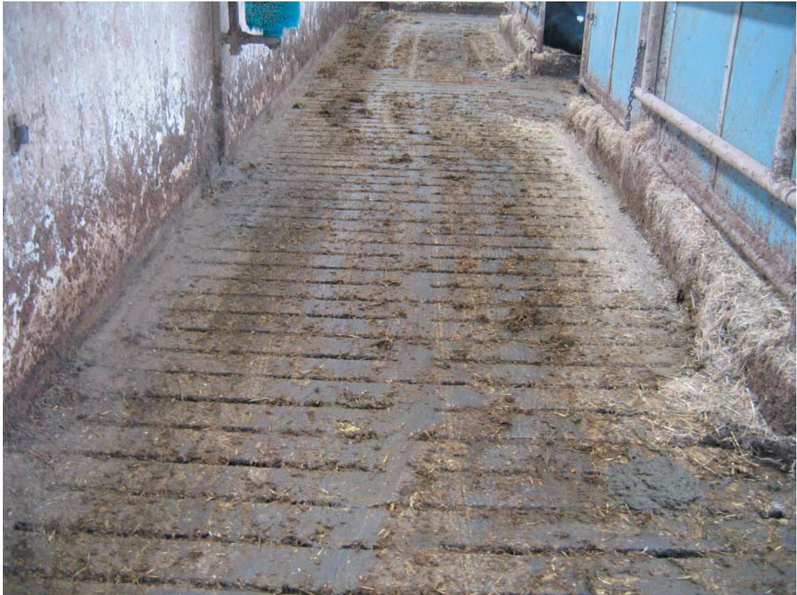
Figur 4.9 Mangelfuld rilleskæring ved passage.
