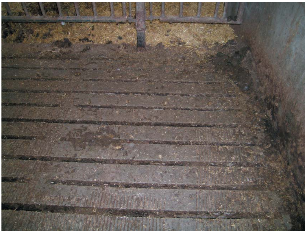
Figur 1.1 Et felt med manglende rilleskæring. Uanset årsag bør landmanden følge op på arbejdet.
