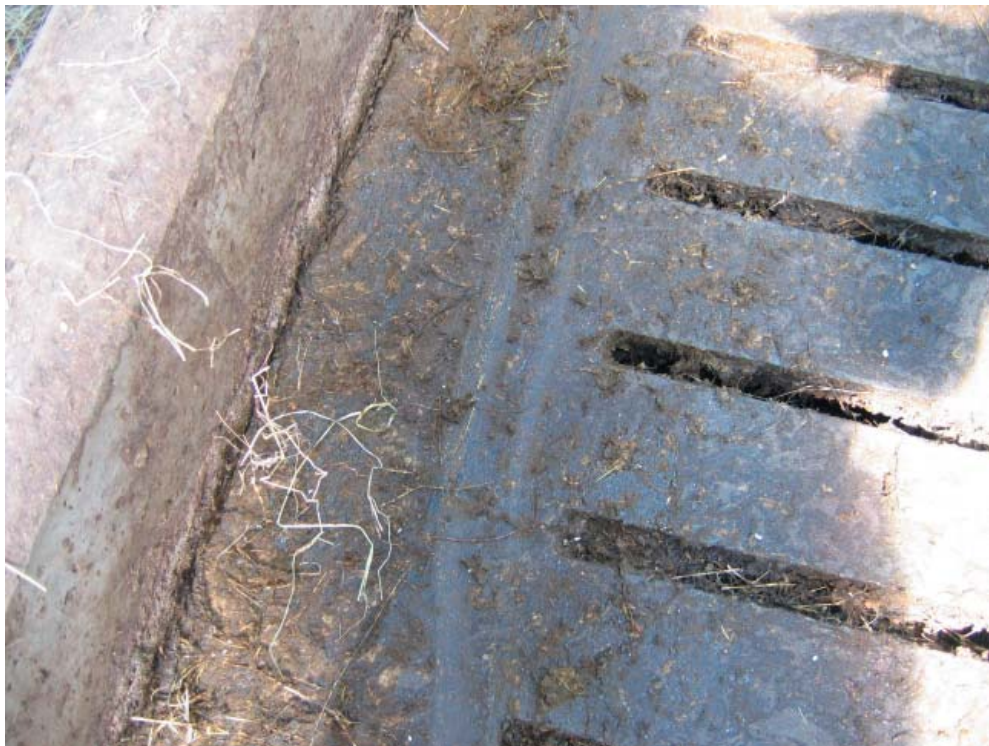
Figur 4.3 Gulv inden rilleskæring. Bemærk den lange udskridning.
