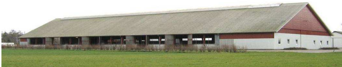
I begge sider af stalden er der en lav mur med gardin over. For hver 4. spær er der en port af gælleplader, som anvendes ved udmugning, der sker fra begge sider af stalden.
