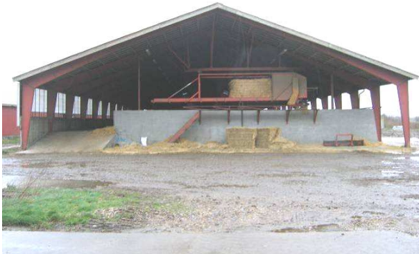
Hævet fodergang betyder at der køres vandret ind ved udmugning. Forlag til strølesshængebane.
