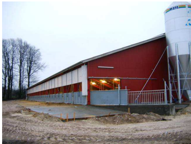
Facade med gardin og låger til udmugning, samt udleveringsrampe i gavlen.
