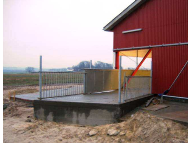
Udleveringsrampen med hegn og udendørs lys. Udleveringsrampen passer med ladhøjden, så kalvene kan gå lige ind i lastbilen.
