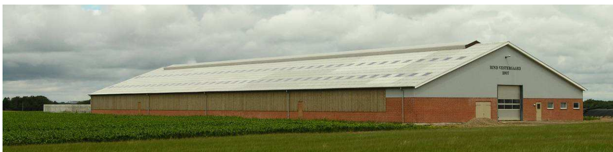
Stalden er flyttet ud på bar mark. Der er bræddetrempele i begge sider.
