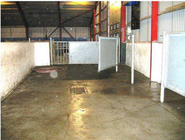
Vejeområde med opsamlingsplads og drivgang til vægten. Det hele kan spules til afløb midt i gulvet.
