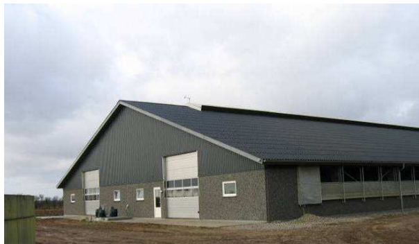
Facade med fjernbetjente rulleporte til de to gennemgående foderborde. Der er en lav mur med gardiner over i begge sider af stalden.
