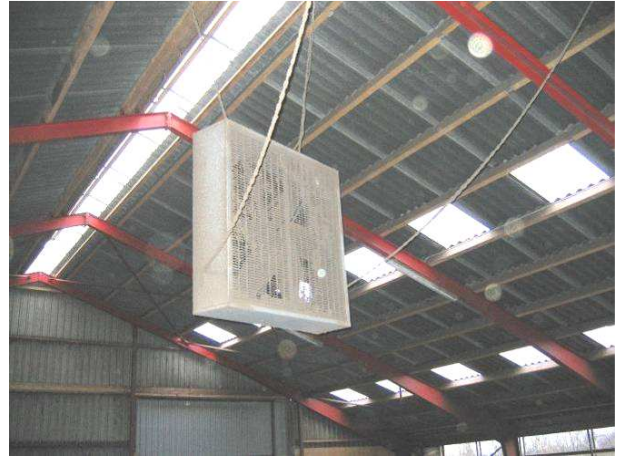
Luftskifte og luftkvalitet i stalden er tilfredsstillende også i vindstille perioder, efter installation af to ventilatorer.
