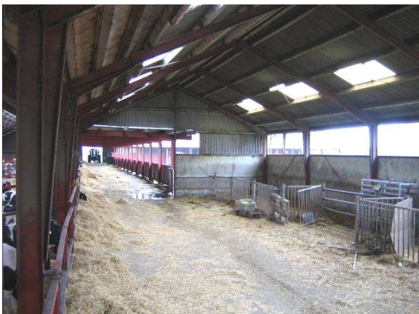
6 meter bred driv- og strøgang bag boksene. Til højre ses veje- og udleveringsområdet.
