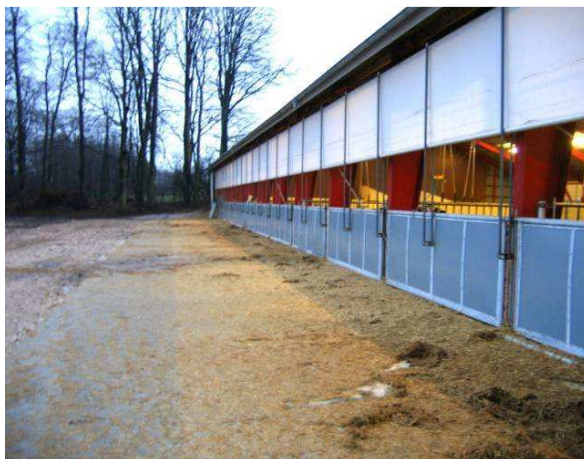
Bred betonvej langs begge staldes sider sikrer gode kørselsforhold ved udmugning.
