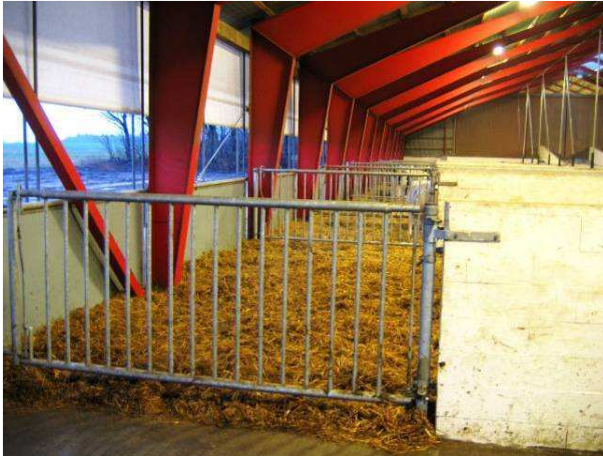
Her ses lågerne bagerst i boksene, som sammen med en låge inde i boksen kan drejes om og lukke kalvene inde i boksene, hvorved der opstår en strøet drivgang.
