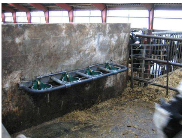
Drikkekopper med afstandsbøjle og afløb med rist i gulvet. Ved de ældste kalve er alle drikkekopper monteret på denne måde.
