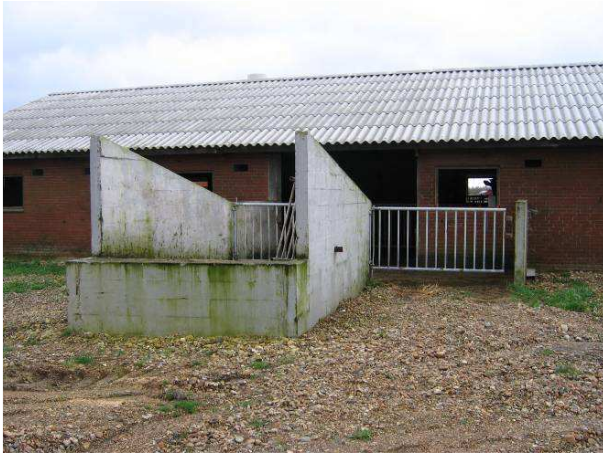
Udendørs udleveringsboks og rampe.
