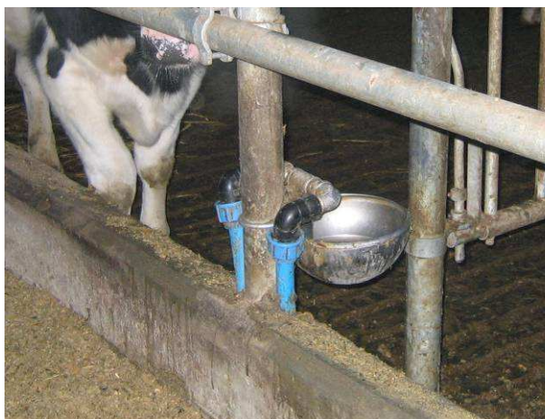
Drikkekopper anbragt over spalterne på ædepladsen.
