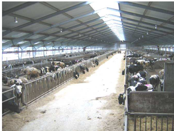
Et blik ned ad den 170 meter lange stalds gennemgående 5,5 meter brede foderbord.
