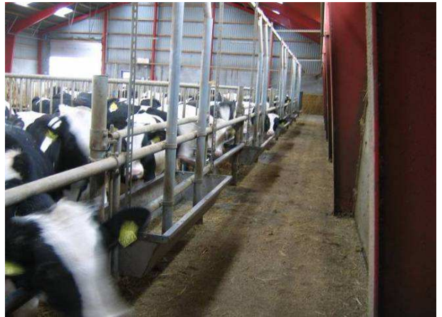
Fodergangen er smal, kun 1,7 meter, hvilket gør det vanskeligt at skifte til fuldfoder.
