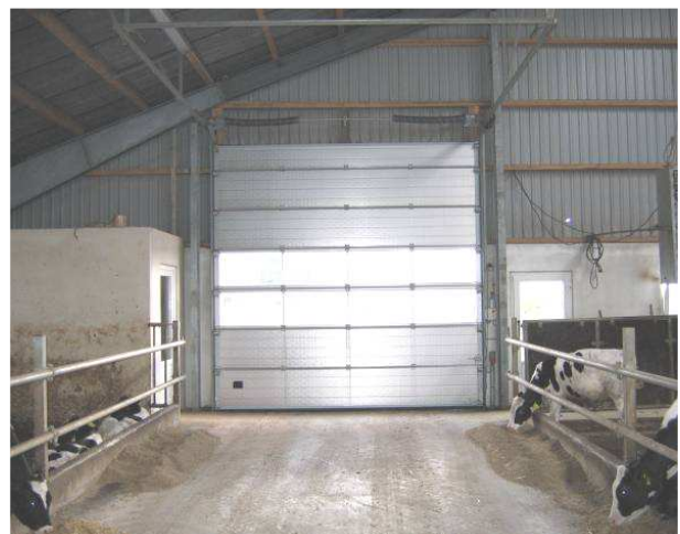
Hejseport med fjernbetjening i alle traktorer.
