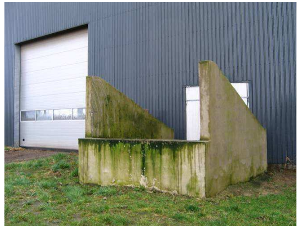
Via udleveringsrampen ledes kalvene direkte ind i lastbilen.
