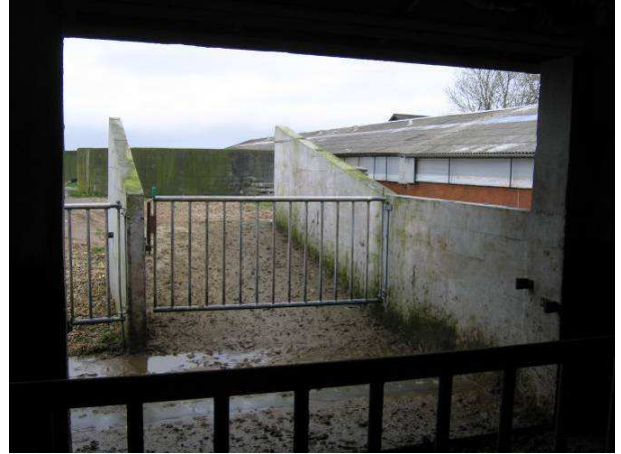
Udendørs udleveringsboks og -rampe. Rampen er rillet for at øge skridsikkerhed.
