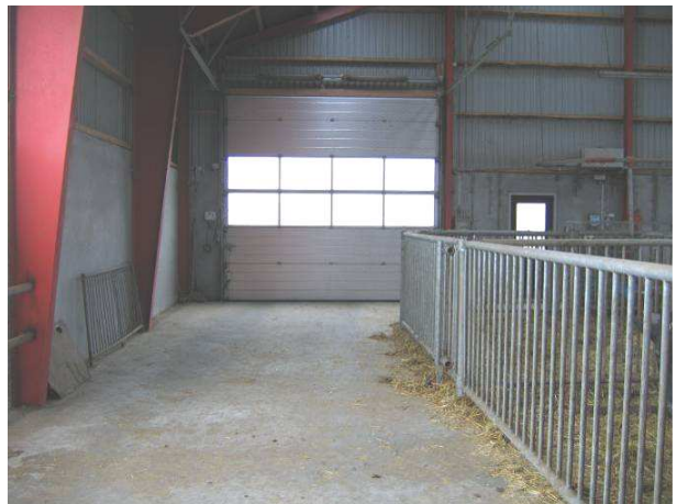
Port til udlevering samt adgang for strømmaskine.
