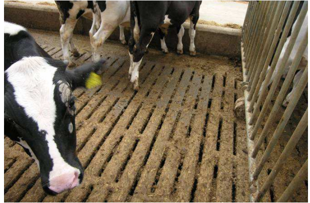
Efter nogle uger med meget varmt og tørt vejr, blev spalterne "runde" af tør gødning. Da det blev mere fugtigt i vejret, blev spalterne efterhånden fri for gødnings-"kager" igen.
