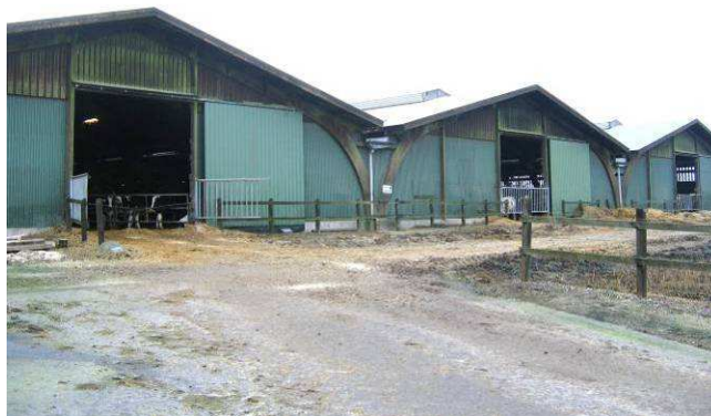
Stalden består af fire sammenbyggede haller. Der er en port i de nordvendte gavle af hver hal.
