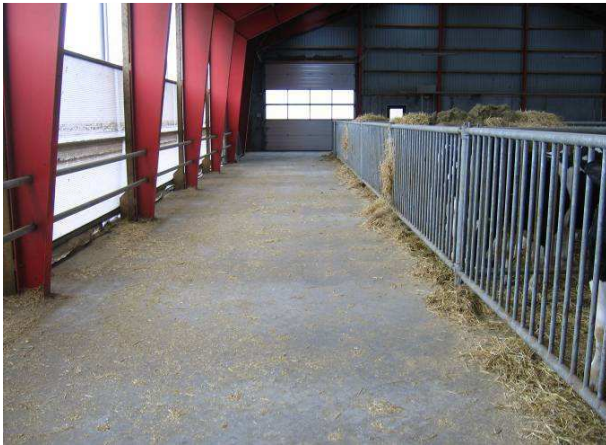
Den brede strøgang betyder, at der ikke blæser halm rundt uden for stalden hver gang, der strøes. Strøgangen fungerer også som drivvej.
