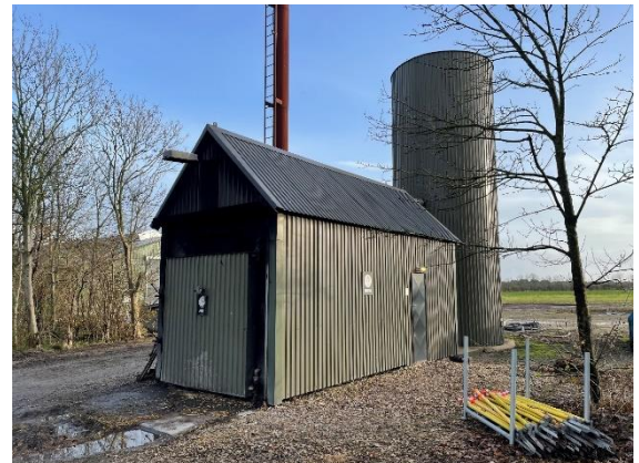
Foto 1. Halmfyr med særskilt akkumuleringsstank
