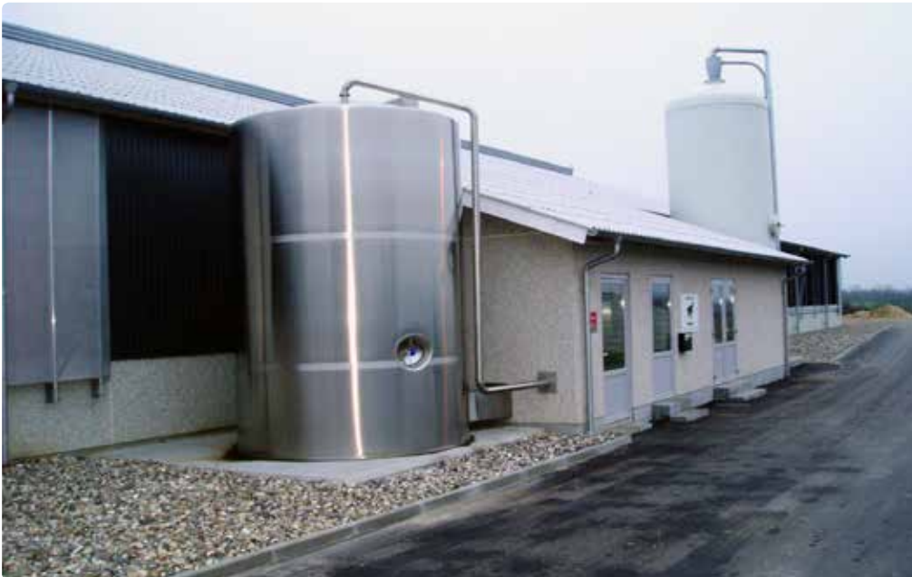
Fig 1. Udendørs placeret mælkekøletank.
