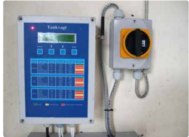
Fig 3. Eksempel på godkendt tankvagt.
