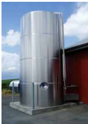
Fig. 6B. Eksempel på nedstøbte pullerter til beskyttelse af tanken.
