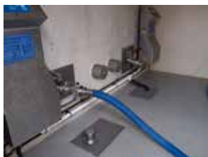
Fig. 6A. Udløbsrør placeret 40-50 cm over gulvet.
