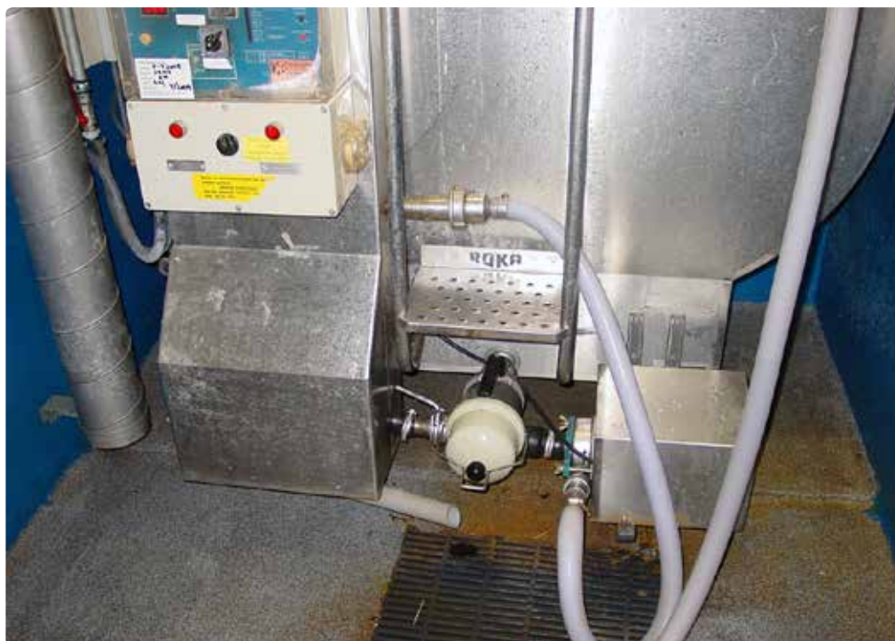
Fig. 2. Buffertank konventionel malkning.
