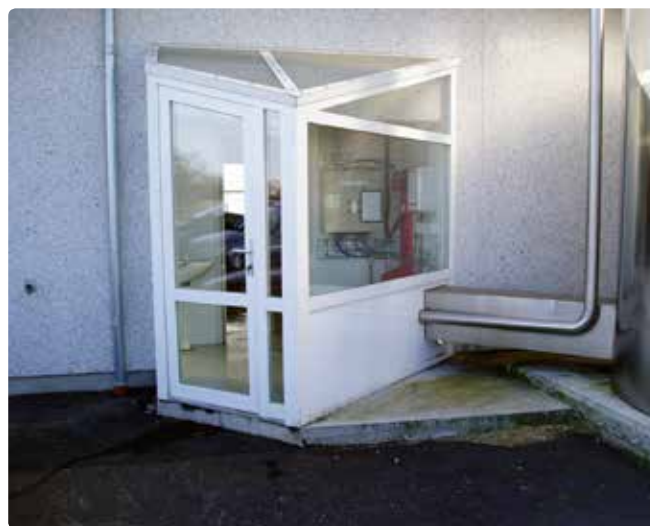
Fig. 10. Model 2. Udløbsrør og udluftning ført til mælkerum.
