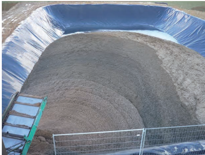
Laguneensilering af snittede roer, som udmærkes ved at være delvis flydende. Dette sikrer en lettere transport fra lager til reaktor.
