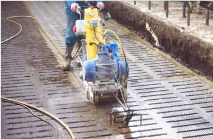
Figur 1.2 Rilleskæring af spaltegulv
