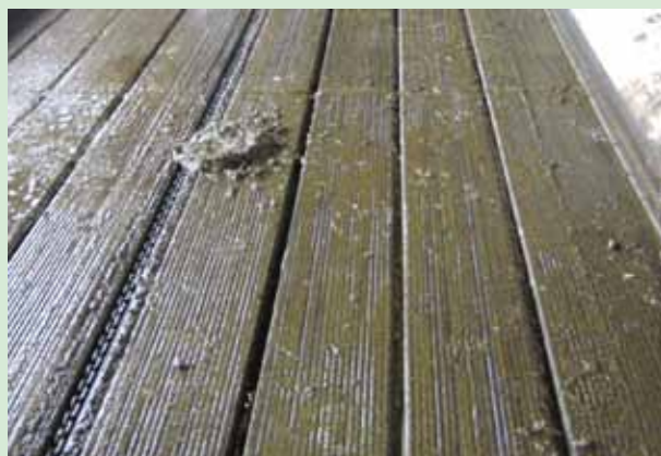
Figur 4.5 Præfabrikeret, fast gulv med dræn og rilleskæring
