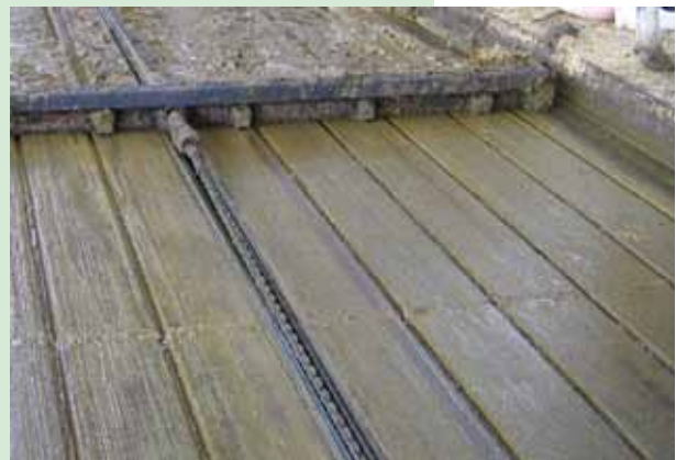
Figur 4.4 Præfabrikeret fast gulv med dræn
