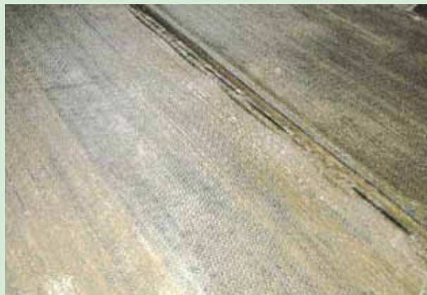
Figur 4.3 Pladsstøbt fast gulv med gummi og dræn
