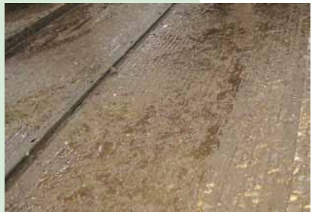
Figur 4.2 Pladsstøbt fast gulv med dræn og sand i sengebåsene
