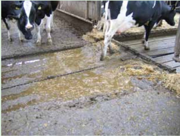
Figur 4.15 Eksempel på en gylletsunami på et fast gulv. Her fungerer dræn og afløb ikke og der er alt for langt til, at skraberen kan komme til at aflevere.
