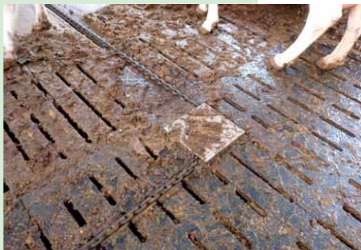
Figur 1.1 Hjørnehjul som kan forårsage klovskader
