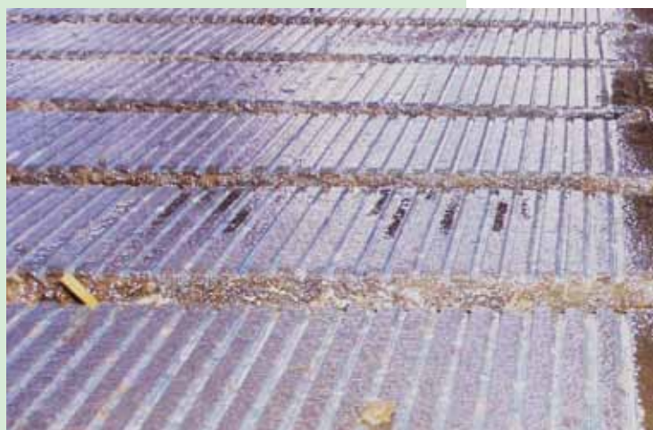
Figur 4.8: Eksempel på rilleskæring af spaltegulv, som det gøres langt de fleste steder – på tværs af spalterne
