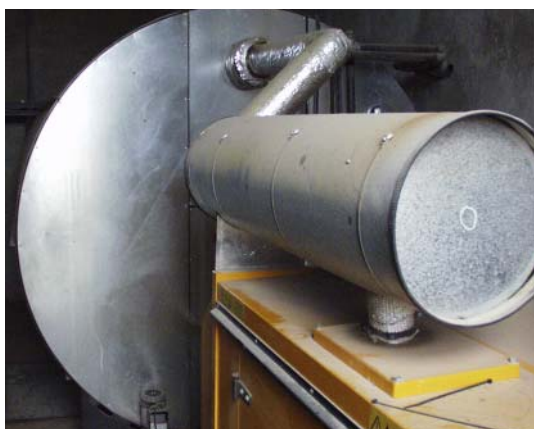
Figur 4.2. Akkumuleringsstank på 68 kW minikraftvarmeanlæg fra KVA Diesel.
