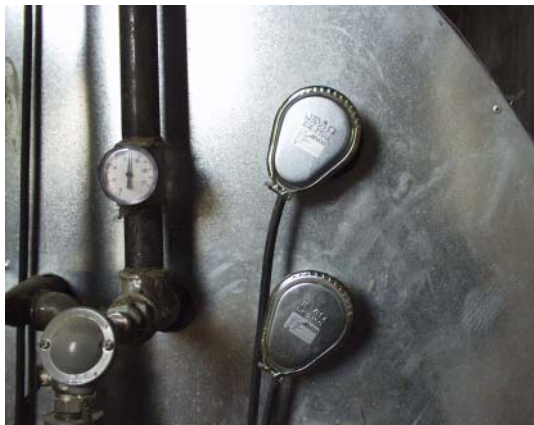
Figur 4.4. Elvarmepatroner i akkumuleringsstanken på 68 kW minikraftvarmeanlæg fra KVA Diesel; bemærk mærkeplade på billedet til højre.
