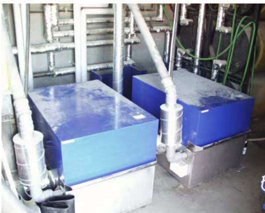
Figur 4.5. To sammenkoblede 17 kW minikraftvarmeanlæg fra EC Power.
