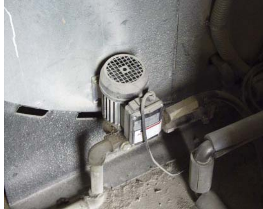
Figur 4.11. Dieseloliepumpe på minikraftvarmeanlæg fra KVA Diesel.
