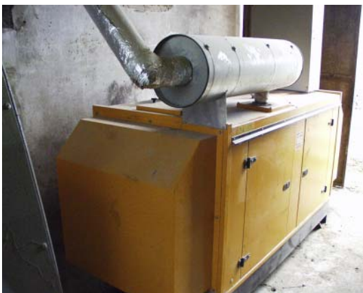
Figur 4.1 Minikraftvarmeanlæg fra KVA Diesel.
