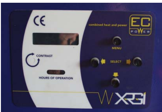
Figur 4.7. Display på styreskab fra 17 kW minikraftvarmeanlæg fra EC Power.
