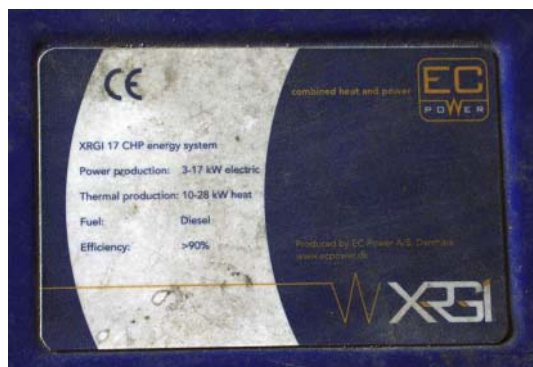
Figur 4.8. Mærkeplade på styreskab fra 17 kW minikraftvarmeanlæg fra EC Power.
