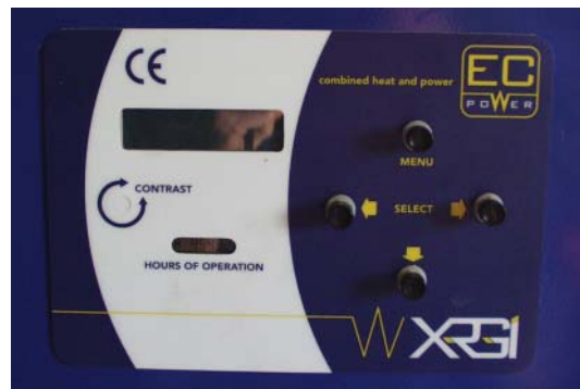
Figur 4.16. Elvisningsdisplay på styreblok på 17 kW minikraftvarmeanlæg fra KVA Diesel.
