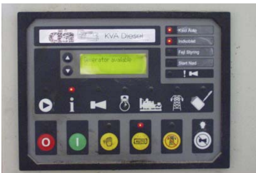
Figur 4.15. Elvisningsdisplay på styreboks på 68 kW minikraftvarmeanlæg fra KVA Diesel.
