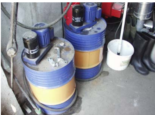
Figur 4.9. En 50-liters smørelietønde tilkoblet motorerne på to sammenkoblede 17 kW minikraftvarmeanlæg fra EC Power.
