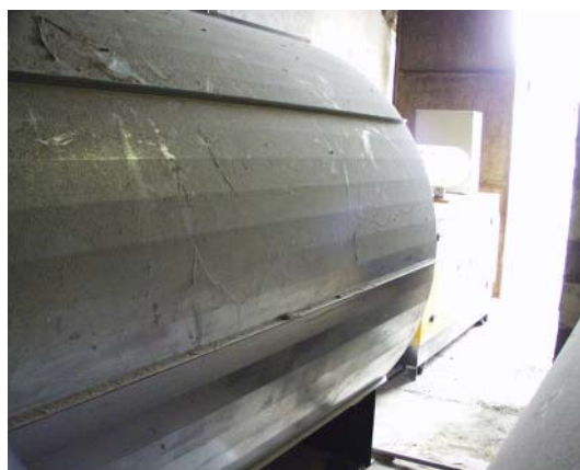
Figur 4.3. Akkumuleringsstank på 68 kW minikraftvarmeanlæg fra KVA Diesel.
