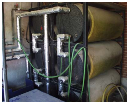
Figur 4.6. Batteri af 500 liters akkumulerings-tanke på minikraftvarmeanlæg fra EC Power.
