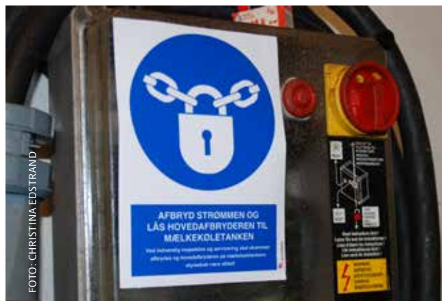
Hovedafbryder med sikkerhedsskilt.
