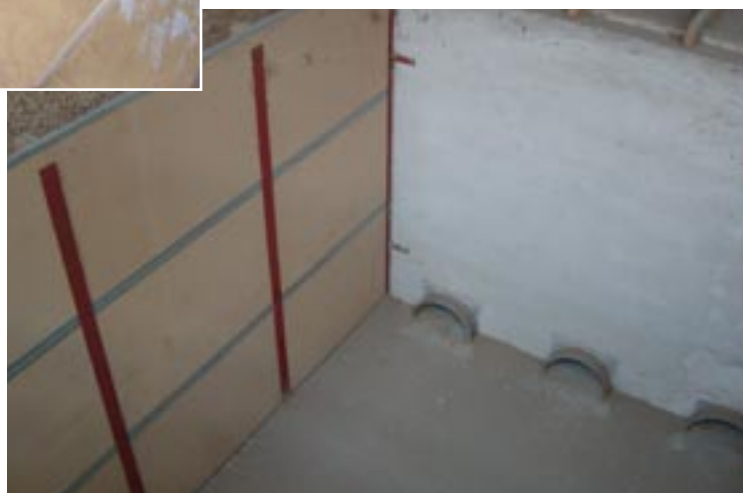
Figur 4.13. Kanalerne skal holdes rene, så luften let kan slippe gennem.
