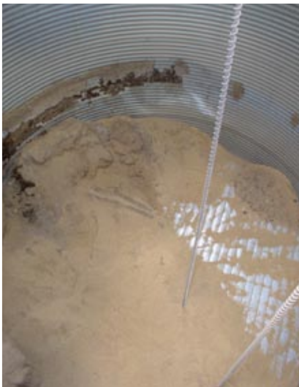
Figur 4.12. Muggent korn langs siden af stålsilo, hvor omrøringsneglen ikke kunne komme helt ud til silovæggen.
