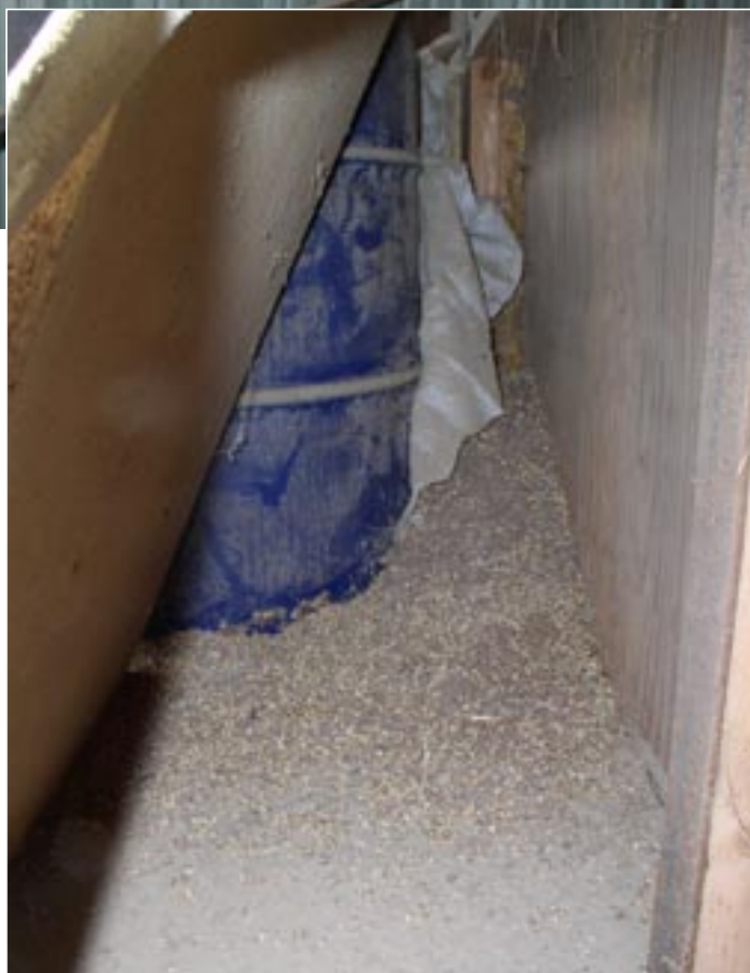
Figur 4.15. Hold rent mellem silovæg og bygning.
