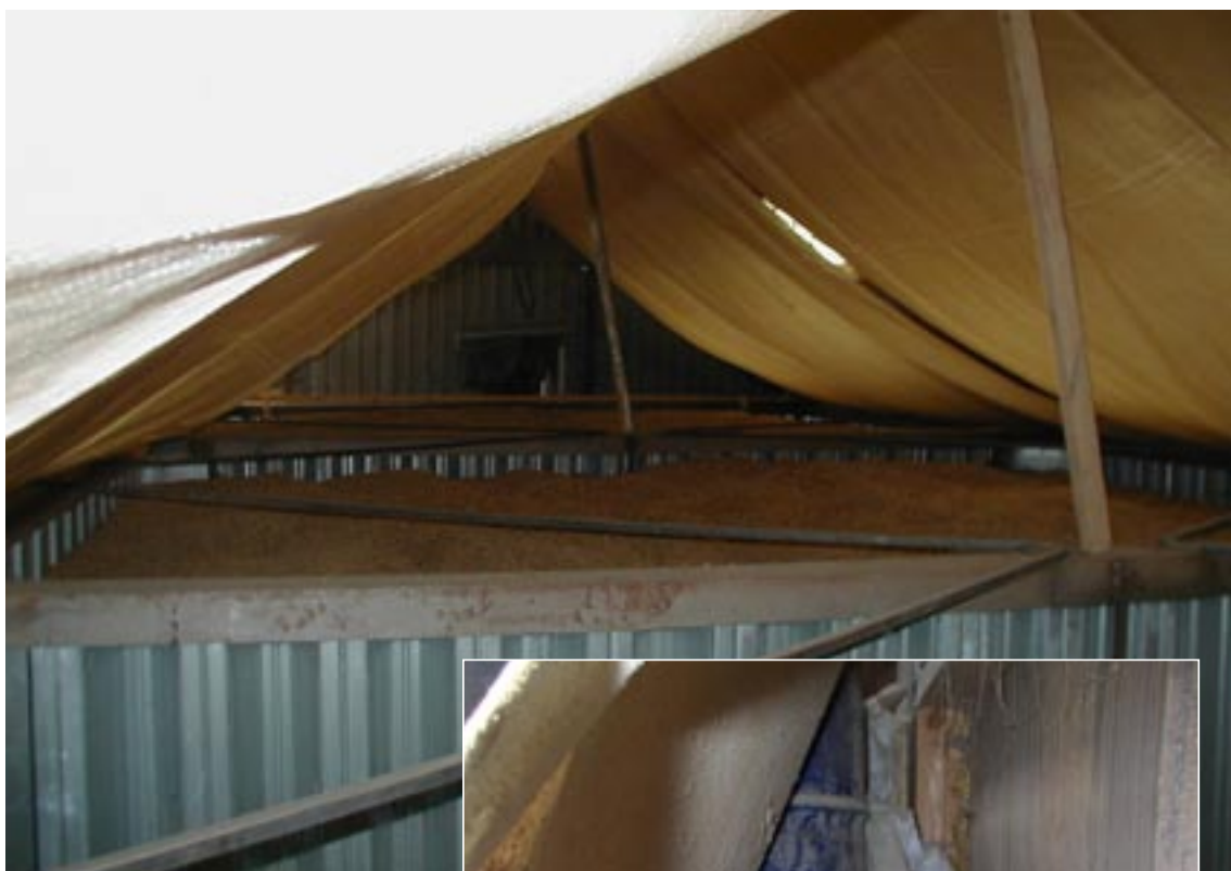
Figur 4.14. Overdækning, der skal forhindre fugleklat i kornet.
