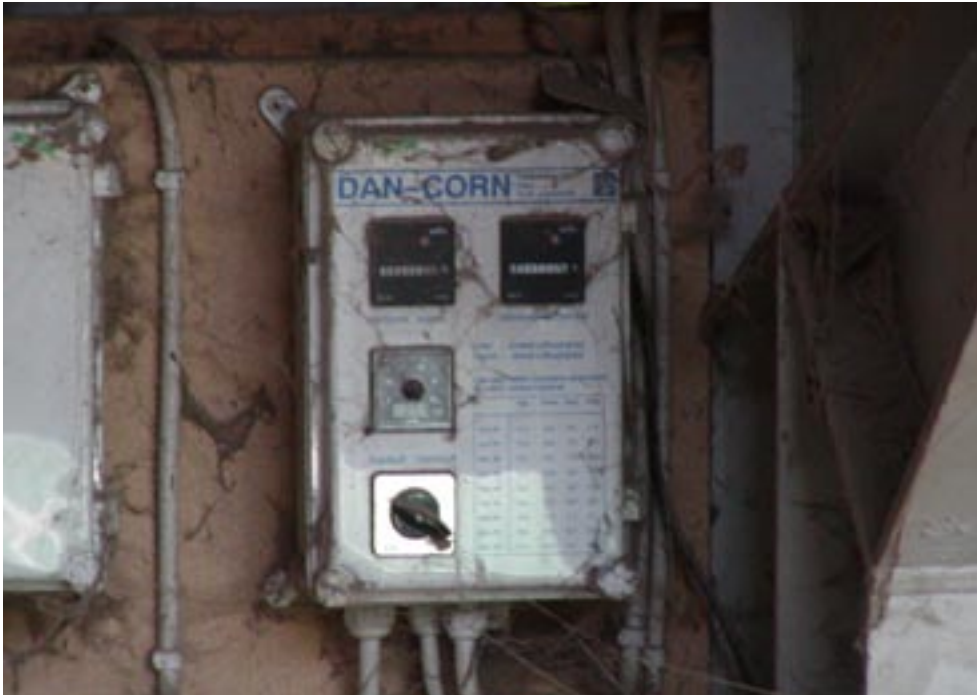
Figur 5.1. Blæserstyring til styring af blæser og varmekilde er en stor hjælp til at sikre et godt resultat med et lavt energiforbrug (Claus styring.jpg)
