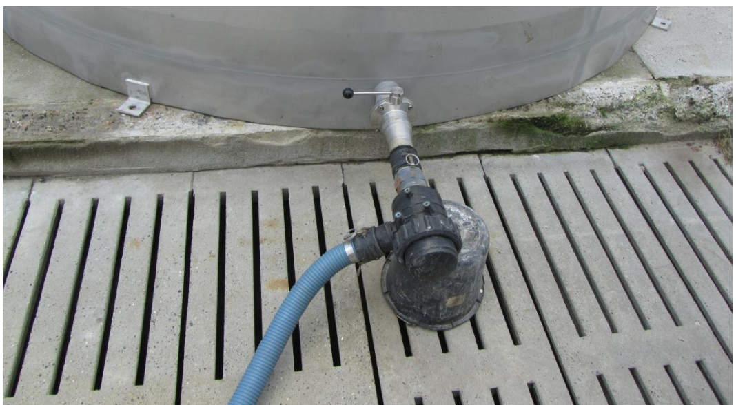
Billede 7. Sugefilter monteret efter udløbet. Bemærk at et eventuelt spild opfanges af spaltearealet.
