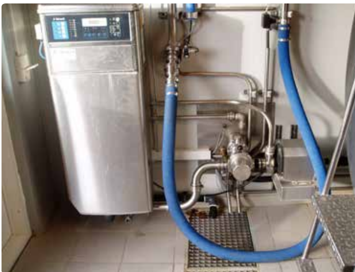
Figur 4. Vaskeautomat til stor udendørs silotank.
