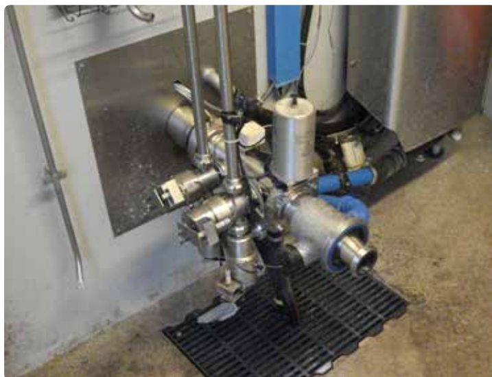
Figur 7. Ventilbatteri fra malkebotter til mælkekøletank.
