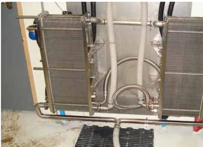
Figur 8. Dobbelt pladekøler på stor side by side malkestald.
