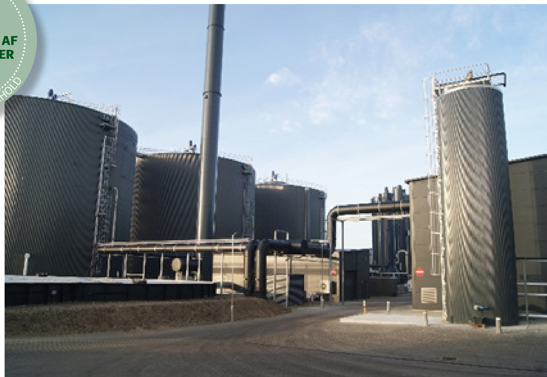
Biogasanlæg. Foto: Erik Fog.
