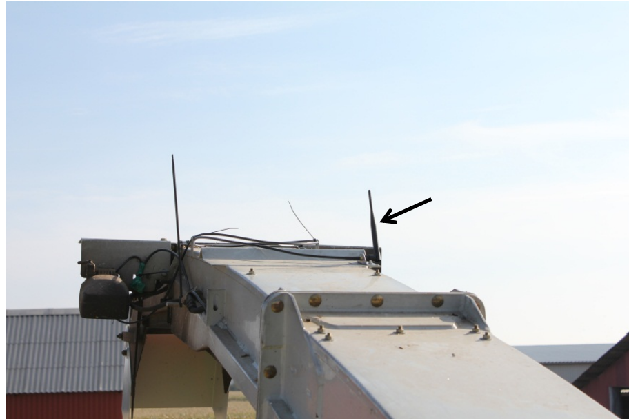
Billede 5. Senderen er indbygget i kameraet. Antennen er kabelført til over tuden.
