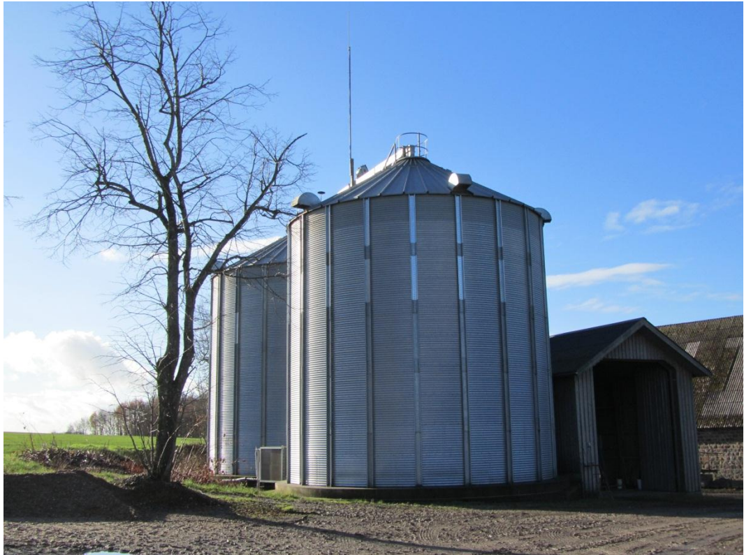
Billede 2. Egen basestation monteret højt på en stålsilo.
