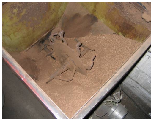
Bemærk omrører i brændselsmagasin.
