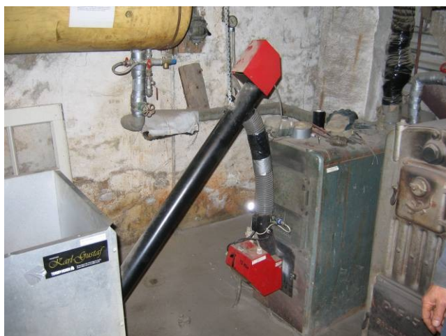
Anlæg anvendt til fortest af pilleflis: Salamander kedel med TB mini dropfaldsstoker.
