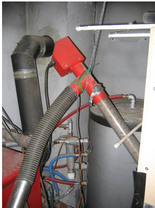
Stokersneglen, bemærk det gennemsigtige og brændselsfyldte plexiglas-sneglerør.
