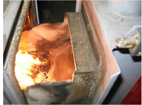
Skrâplade i Iwaho-brændhovedet, hvor brændslet triller ind i kedlen.
