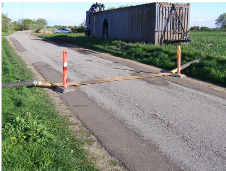
Figur 8. Eksempel fødeledningens passage af vej gennem fladt stålrør.
