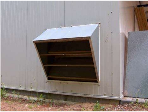
Eksempel på indsugningsventil med spjæld og temperaturføler
