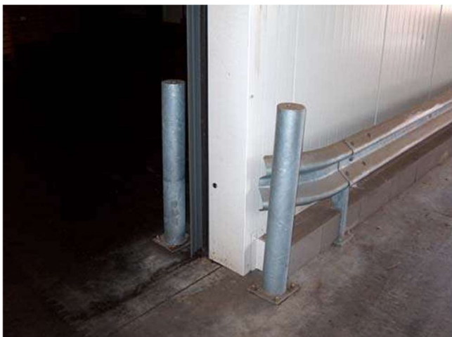
Sandwichelementerne og portåbninger beskyttes med kraftigt truckværn
