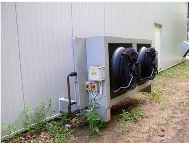
Typisk placering af kondensator
