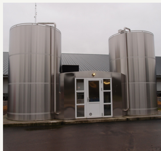
2 lige store tanke med integreret afhentningsrum
