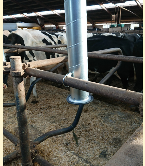
Udsuget er placeret ca. 15 cm under sengebåsens øverste frontrør. Foto: SEGES
