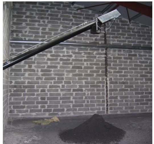
Askesnegl og aske i askerummet.
