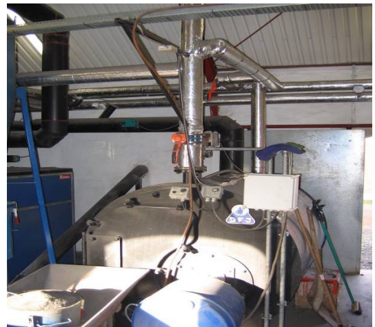
Oliefyr til backup.
