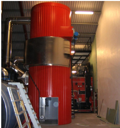
Beholder (rød) med filterposer til opfangning af flyveaske.
