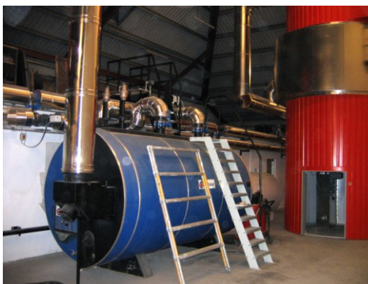
2,0 MW oliefyret backup-kedel.
