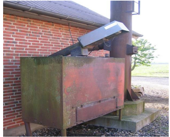
Olietank ombygget til askebeholder.
