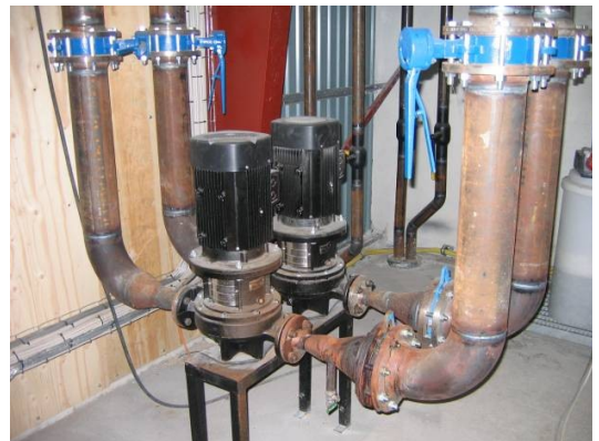
Pumper til cirkulation af vandet i fjernvarmenettet, den ene er reserve.
