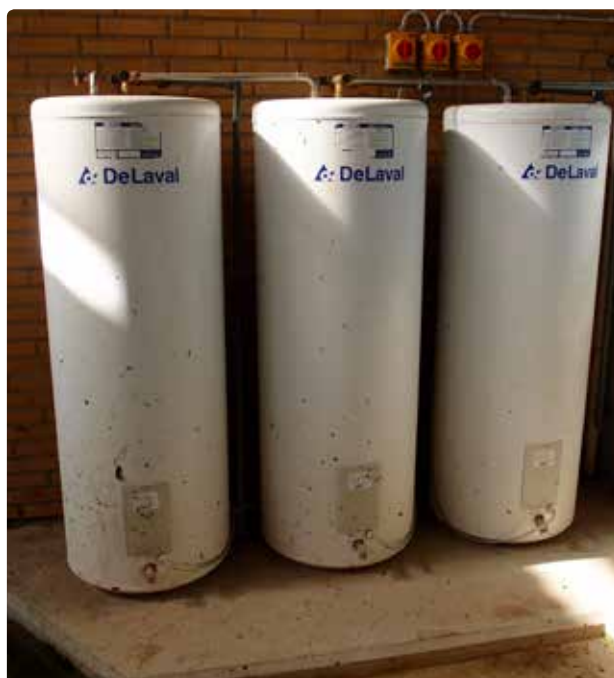
Figur 1. Tre x 300 liter el-vandvarmere opstillet i serie.
