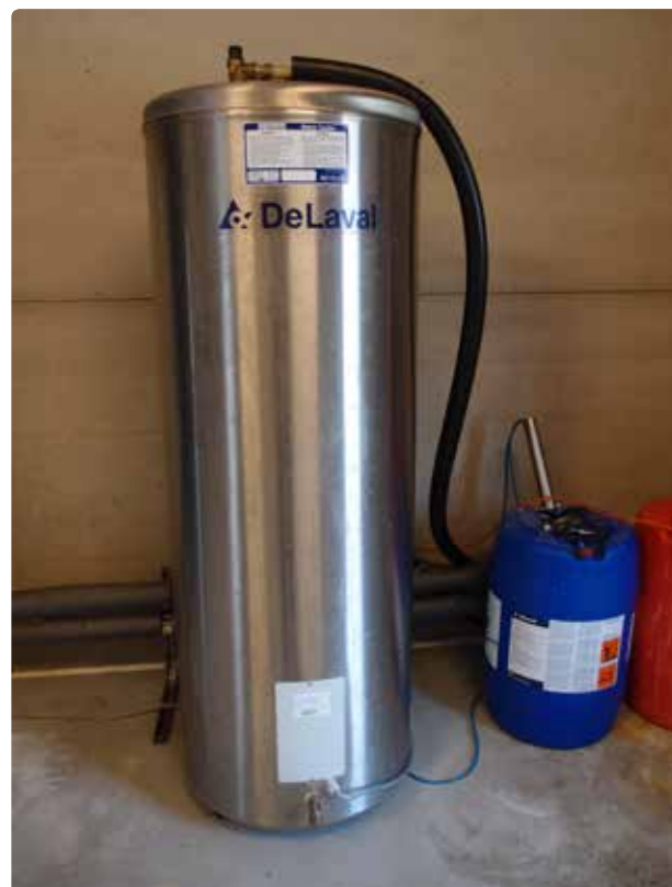
Figur 2. En 300 liter el-vandvarmer – enkeltopstilling.
