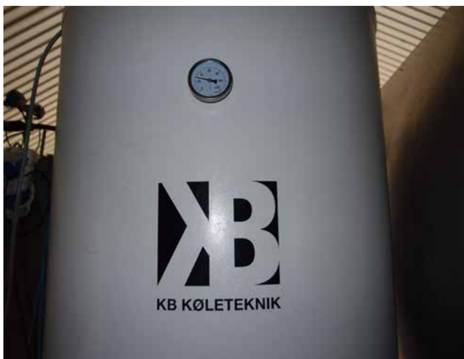
Figur 5. 375 l el-vandvarmer fra KB Køleteknik.
