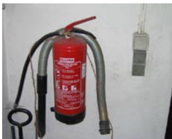
Brandslukker placeret i fyrrummet.
