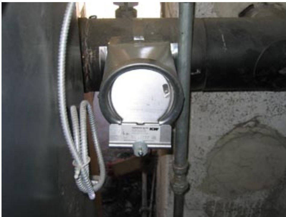
Trækstabilisator på fyret på ejendom nr. 3.
