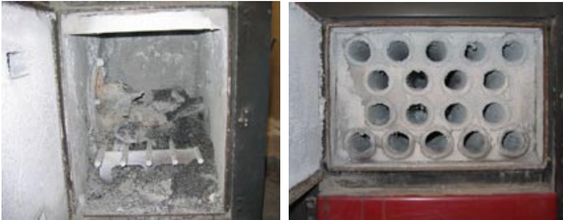
Kedel og konvektionsrør. Bemærk slagger og stærkt tilskede konvektionsrør, som trænger til rengøring. Den lyse askefarve omkring konvektionsrørene vidner i øvrigt om god forbrænding.
