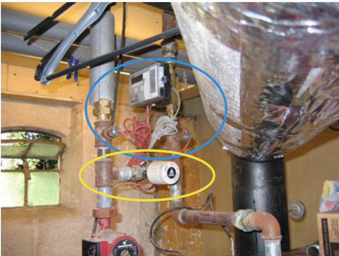
Placering af varmemåler i forhold til shunten på fyret på ejendom nr. 1. Shunten er afmærket inden for den gule ellipse. I den blå ellipse ses varmemåleren med de to termofølere.
