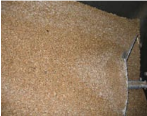
Bemærk spor af kridt i kornet i magasinet på fyret.
