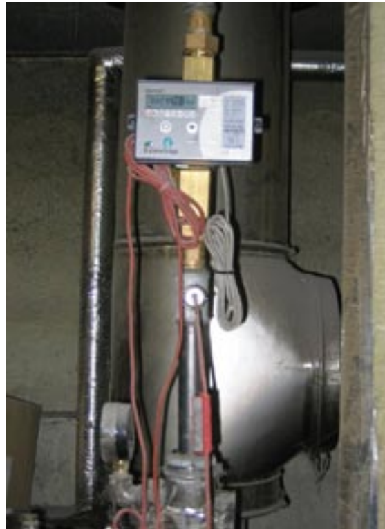
Varmemåler monteret i fremløb.
