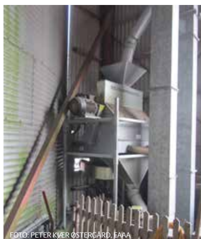
BILLEDE 15 Vestjysk kornrenser monteret mellem korngrav og transportelevاتور. FOTO: PETER KJÆR ØSTERGÅRD, EAAA
