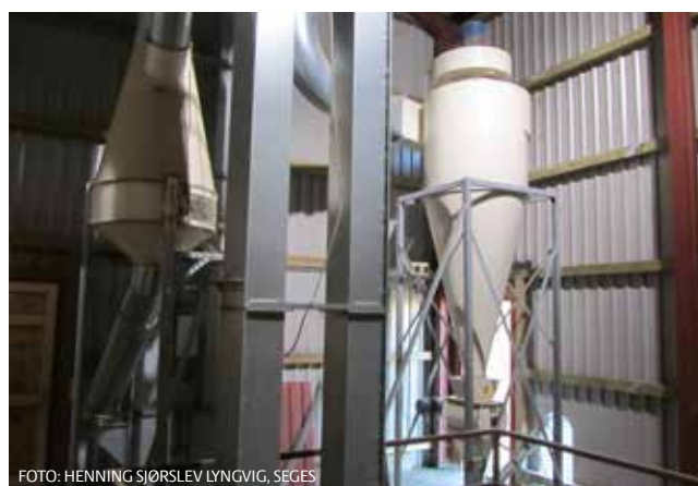
BILLEDE 7 Pulco forrenseren ses til venstre. Til højre ses cyklonen, hvor frørensset afleveres til en snegl. Cellehjulet i bunden af cyklonen forhindrer luftstrømmen i at blæse forurenset luft ud i rummet.
