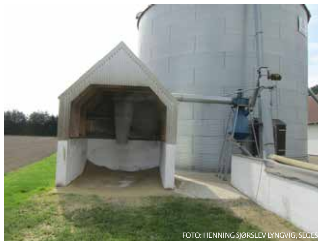
BILLEDE 13 Cyklon monteret i et fint lille hus, hvor frænsset placeres. Bemærk den kørefaste mur, der gør tømning med frontskovl let.
