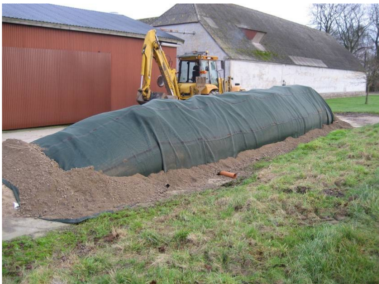
Figur 7. Posen bør beskyttes med net. Nettet er hævet fri af posen med brugte bildæk og holdes fast med sand. Foto Niels B. Andersen, Horsens Maskiner.
