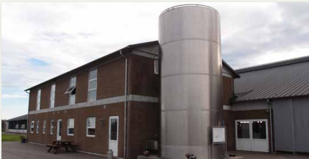
Servicebygning indeholdende mælkerum, teknikrum og personalefaciliteter.
