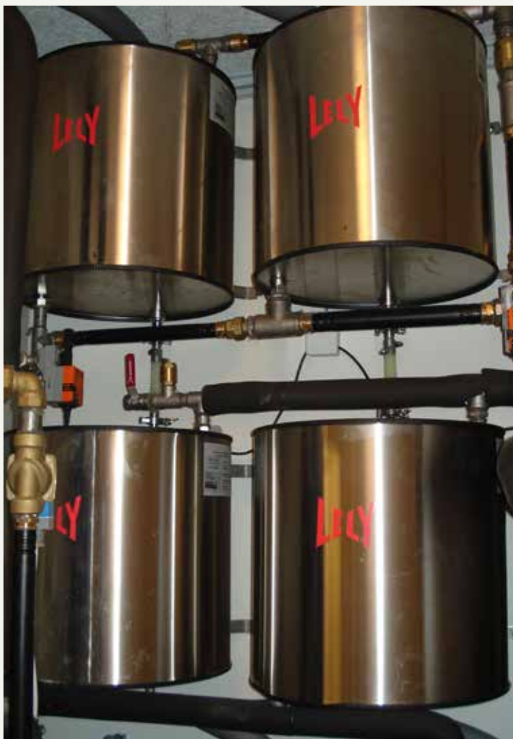
Rørkøler på AMS anlæg kølet med isvand.
