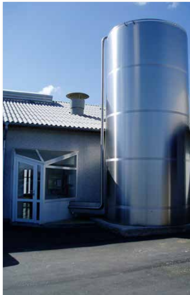
Aftrækskorsten med ventilation ført op gennem loftet.
