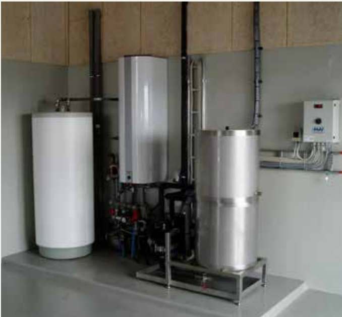
VVS installation i stald med AMS. Hovedindføring af vand, beholder til varmegenvinding, varmtvandsbeholder og tank til isvand. Unit til frostsikring af drikkevand i stalden.
