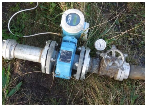
Billede 9. Prøvepumpning af boring med elektronisk vandmåler med direkte aflæsning af vandgennemstrømningen. Bemærk skydeventilen og manometeret.
