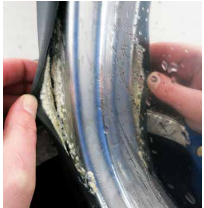
Fig 4. Belægninger ved pakning til mandeluge.
