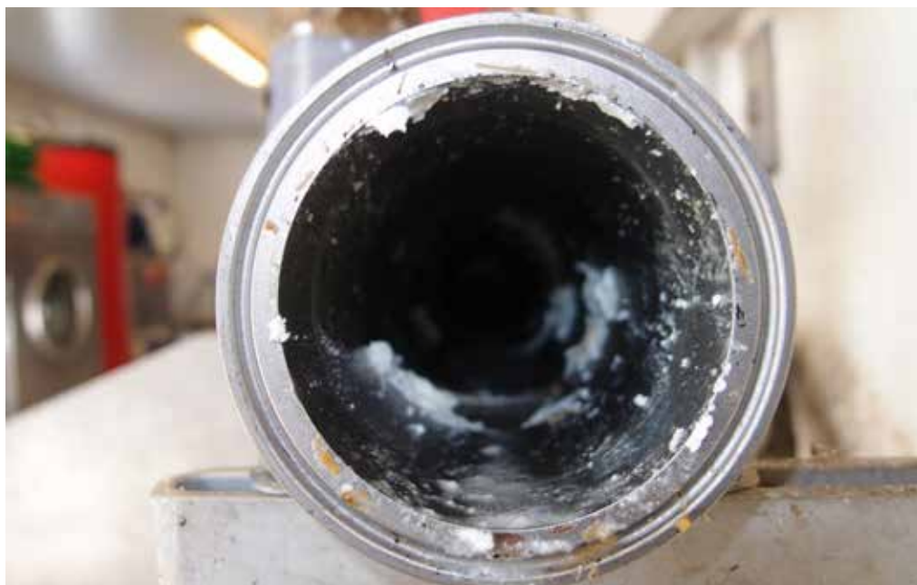
Fig. 2. Belægninger i filterhus.
