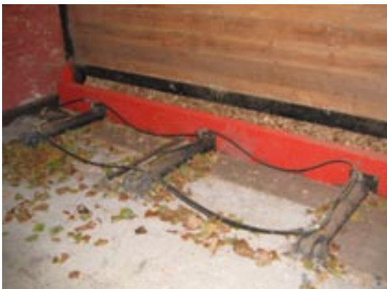
Figur 5.6. De tre hydraulikstempler, som trækker flisen hen til indfødningsneglen til fyret.
