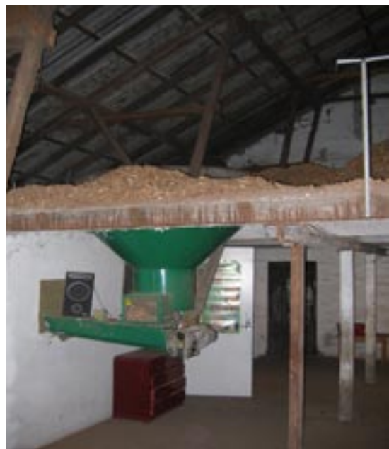
Figur 5.25. Flismagasin på loft. Flisen flyttes op på loftet med teleskoplæsser.
