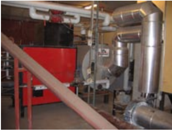
Figur 5.15. Flisfyret på 500 kW. Den røde kasse er selve brændkammeret. Til højre for brændkammeret ses den cylinderformede rørkedel, hvori røggasserne afkøles.
