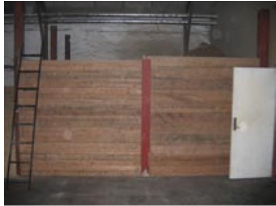
Figur 5.36. Flisiloen til 150 kW fyret.
