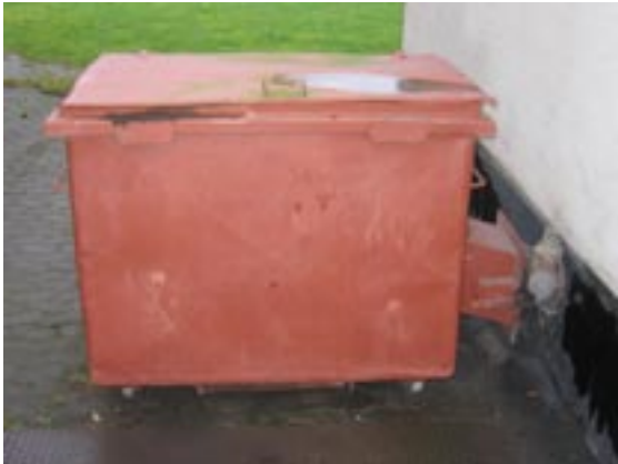
Figur 5.18. En mindre container til opsamling af aske er placeret udendørs. Bemærk, at containeren er koblet til en studs i soklen. Gennem studsen føres asken fra fyret ud til containeren.
