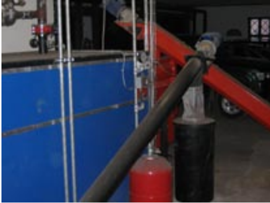
Figur 5.9. 250 kW flisfyre med flisnegl og cellesluse i baggrunden, og askesnegl med askespad i forgrunden.
