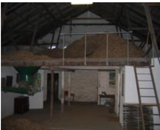
Figur 5.25. Flismagasin på loft. Flisen flyttes op på loftet med teleskoplæsser.
