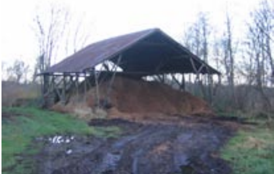
Figur 5.23. Stakladen hvori pileflisen lagres. Bemærk den opkørte jordvej hen til stakladen.
