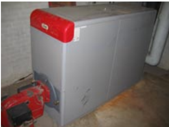
Figur 5.17. Oliefyr på 240 kW. Starter, hvis flisfyret svigter eller stoppes.
