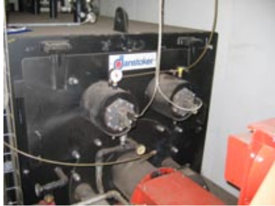
Figur 5.10. De to ventiler (midt i billedet) til automatisk tryklufrensning af kedelflader og konvektionsrør monteret i kedellågen.
