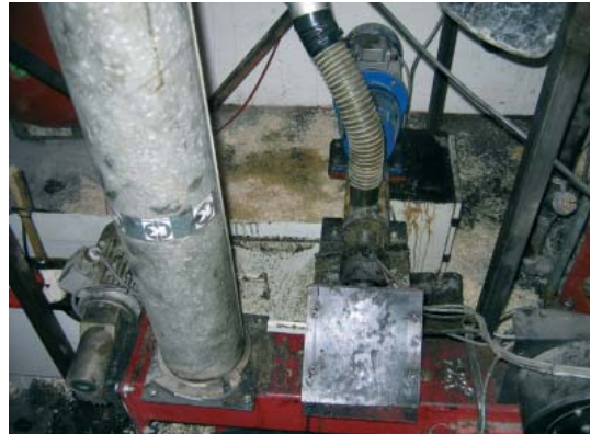
Figur 5.11. OK-røret leder det fransede materiale fra rysterenseren uden om oliepresseren og direkte ind i stokeren.
