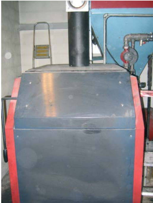
Figur 5.6. 125 kW biobrændselsfyr. Silo/brændselsmagasin ses i baggrunden.
