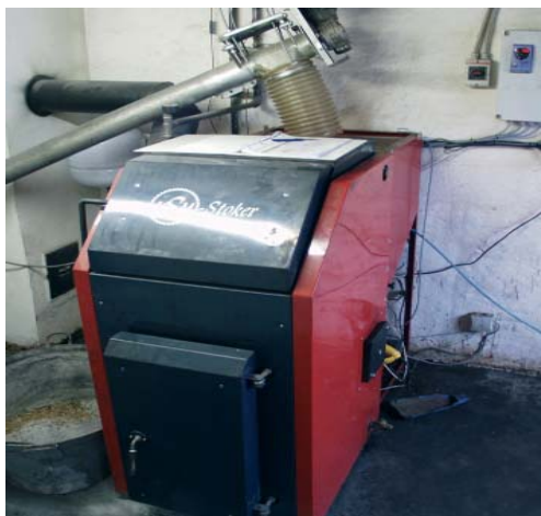
Figur 5.1. 20 kW rapskagefyret biobrændselsfyr med integreret rapsoliepresser.
