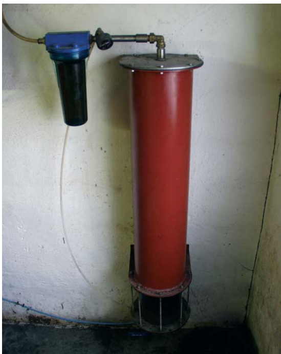
Figur 5.4. Rapsolien trykkes igennem det røde søjlefilter. Olien ledes ind forneden og forlader filteret foroven. Til venstre for søjlefilteret er der et ekstra lille filter.
