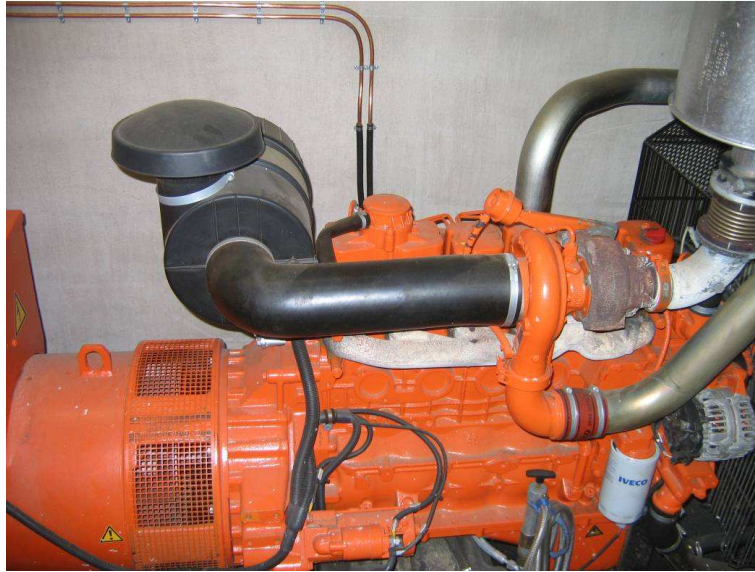
Figur 6. Dieselgenerator til drift af varmepumpe.
