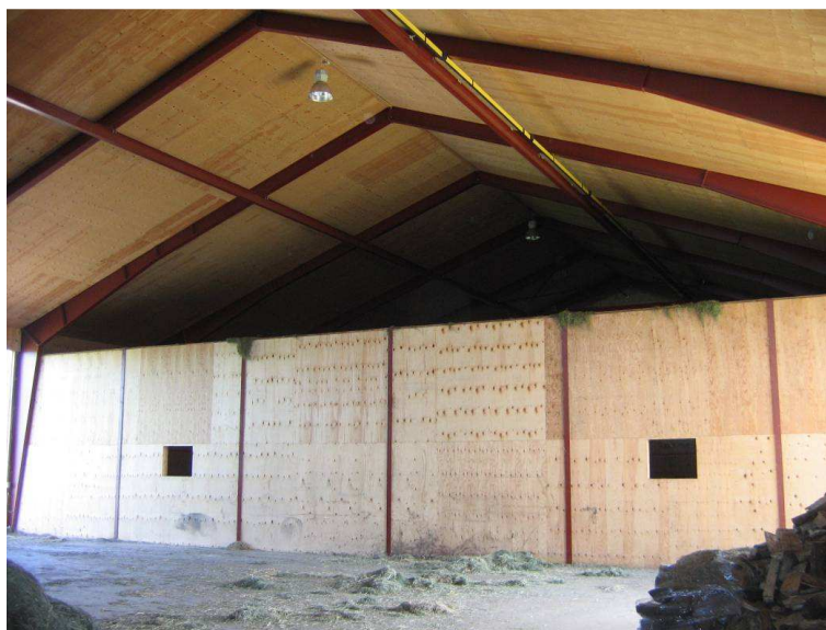
Figur 3. Den 5 meter høje silovæg.
