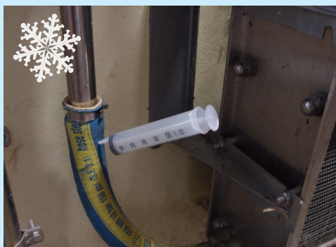
Udtagning af mælkeprøve før og efter pladekøleren for at tjekke om den er utæt. Foto: SEGES
