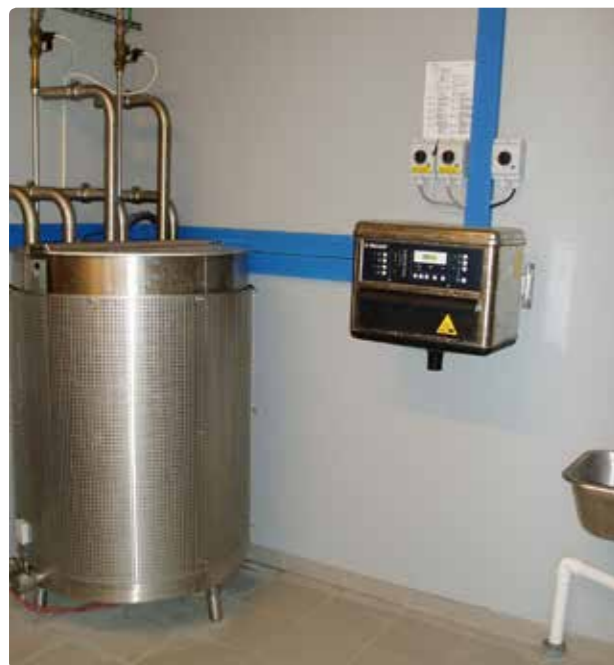
Figur 3. Vaskeautomat til stor malkestald.
