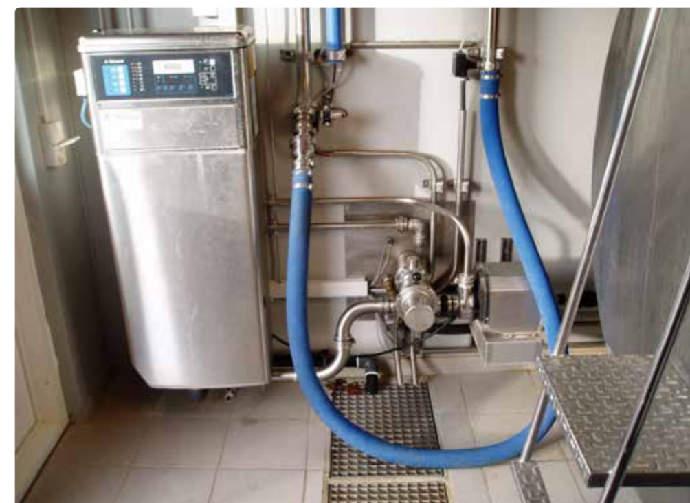
Figur 4. Vaskeautomat til stor udendørs silo-tanke.
