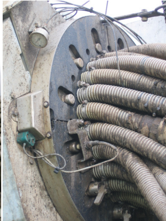
Figur 5.6 Sektionsfordeleren. Bemærk tappene i slidserne ved siden af slangerne ud mod periferien - de angiver om spadeventilerne er åbne eller lukkede; i den viste situation er de alle lukkede.
